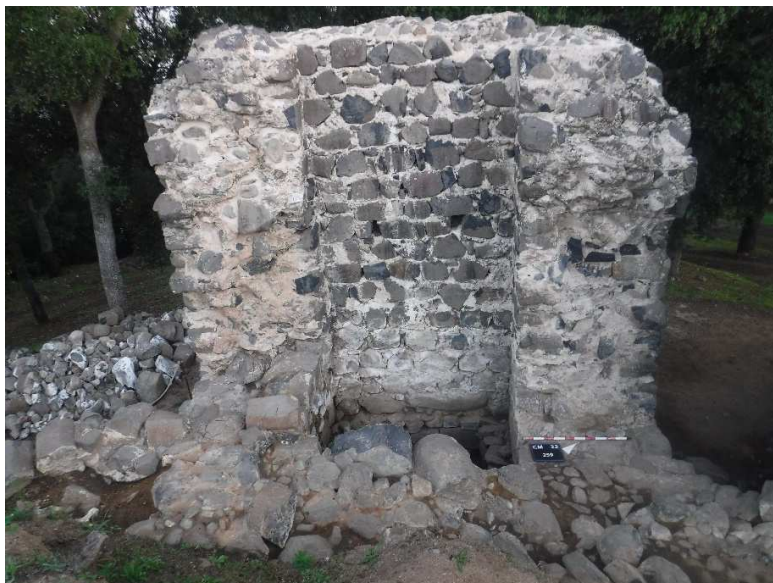
10. General de la torre nord-oest al final de la intervenció.
