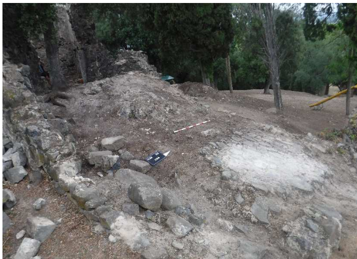
22. Sector 35 a l'inici de la intervenció, amb l'enderroc del mur nord de la capella.
