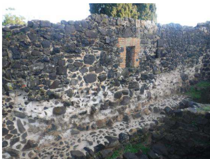
35. Arranjament de la part malmeda de la cara interna de la muralla nord.
