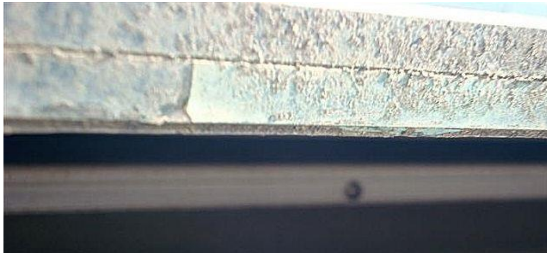
Acabado borde inferior
