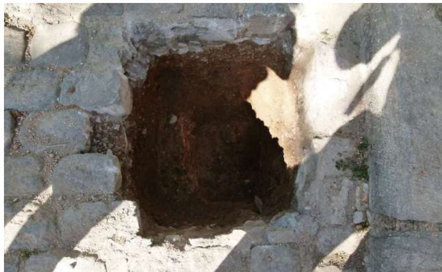
Figura 23: Cala 1 (clau arc 1) excavada fins al final (24/04/2017).
