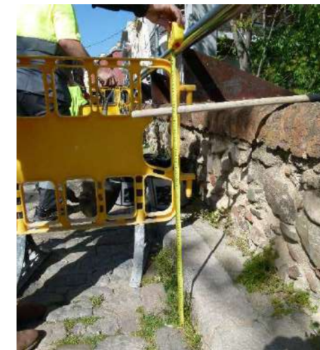
Figura 21: Altura del parapet al costat de la cala 1: 78 cm (24/04/2017).
