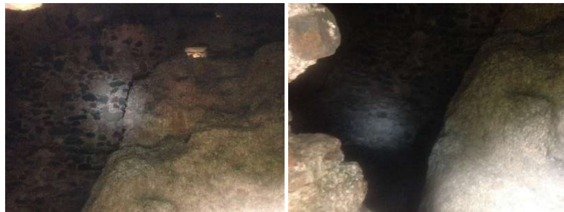
Figura 20: Interior de l'espai de la volta de l'arc 4 (fotografia de la brigada municipal).
