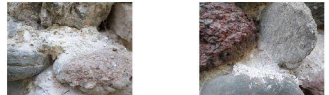
Figura 16: Morter de calç desfet a l'arrencada de l'arc 2 (10/05/2017).
