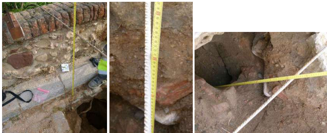
Figura 26: Cala 3: mida del parapet, fondària de l'extradós i l'intradós de l'arc (5/05/2017).
