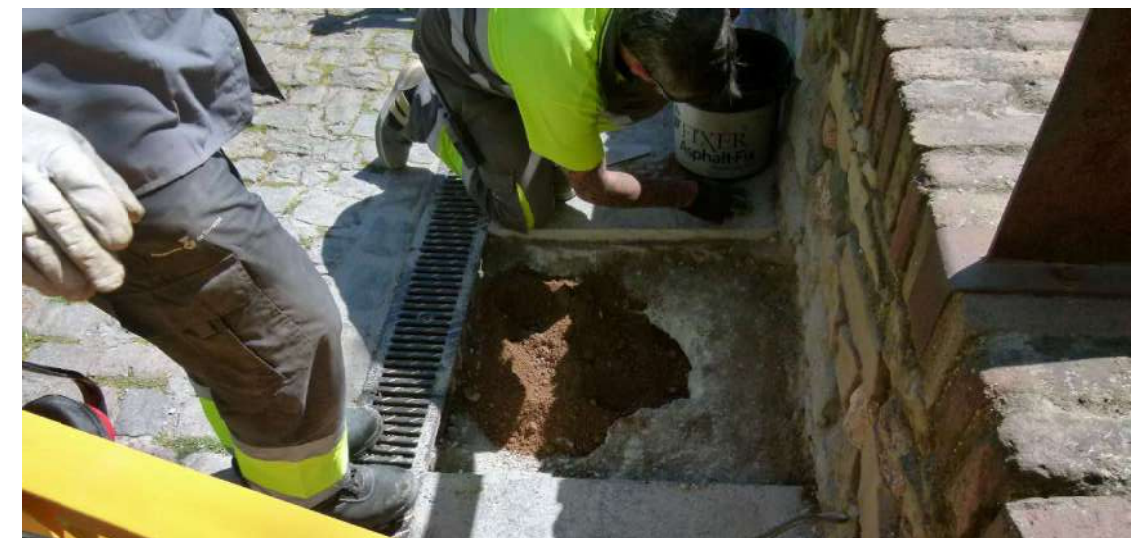
Figura 25: Cala 2 en excavació: llambordes, moter d'adherència i planxa de formigó de 15 cm (24/04/2017).
