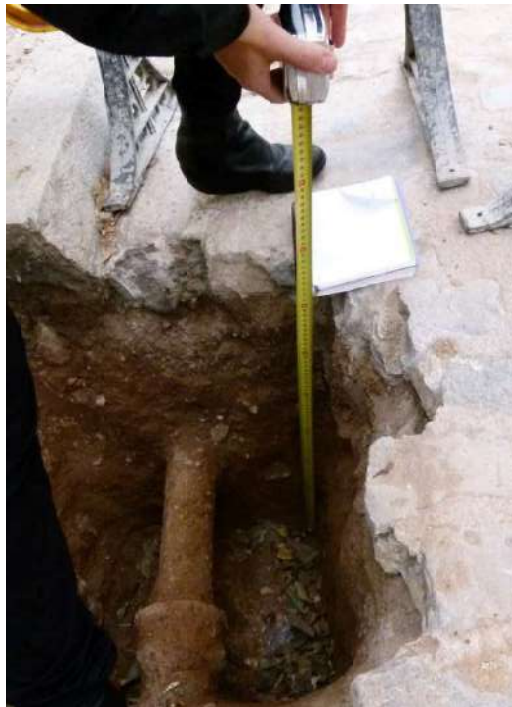
Figura 4: Cala damunt la clau de l'arc 3 (18/12/2017).
