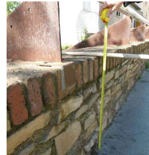
Figura 24: Altura del parapet a la cala 2, damunt el pilar 1 al costat Sud (24/04/2017).
