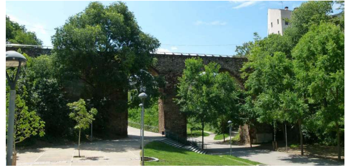
Figura 6: Urbanització sota el pont del parc de Vallparadís (10-05-2017).
