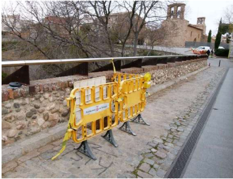
Figura 3: Fotografia de l'emplaçament de la cala damunt el pont (18/12/2017).
