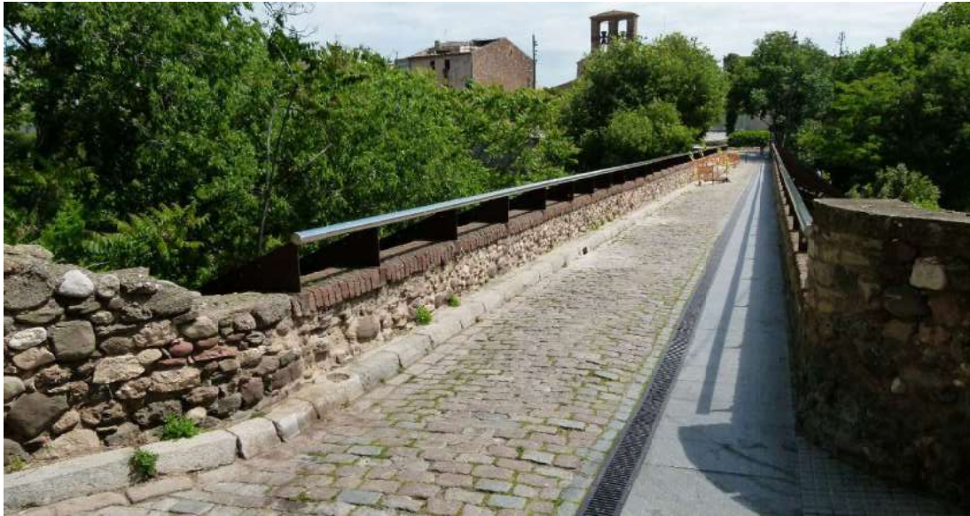
Figura 5: Plataforma actual amb el passamà afegit i el paviment de granit amb reixa (10-05-2017).
