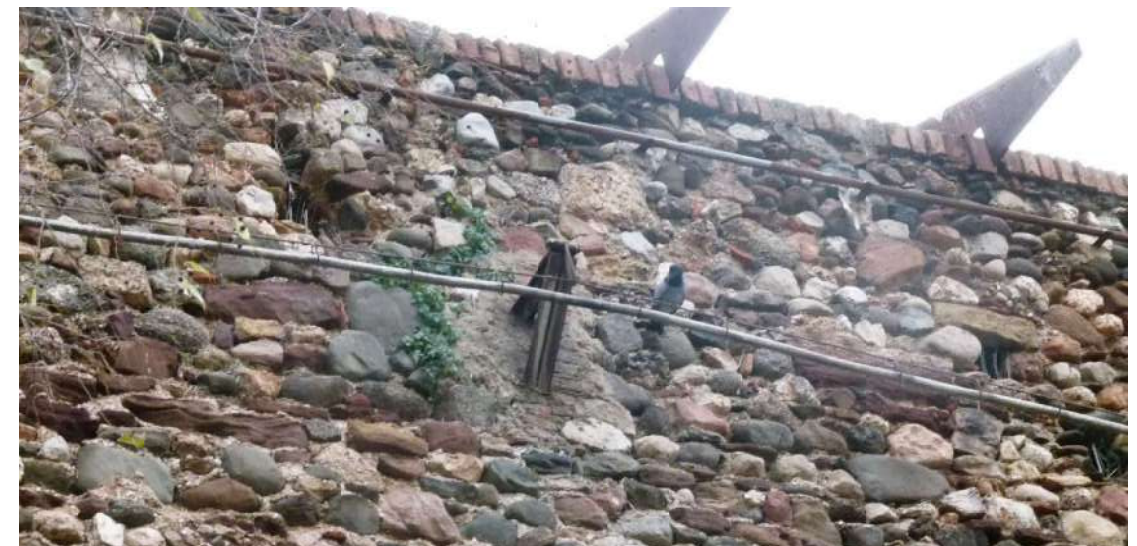
Figura 21: Fotografia dels serveis sospesos en el parament Nord.
