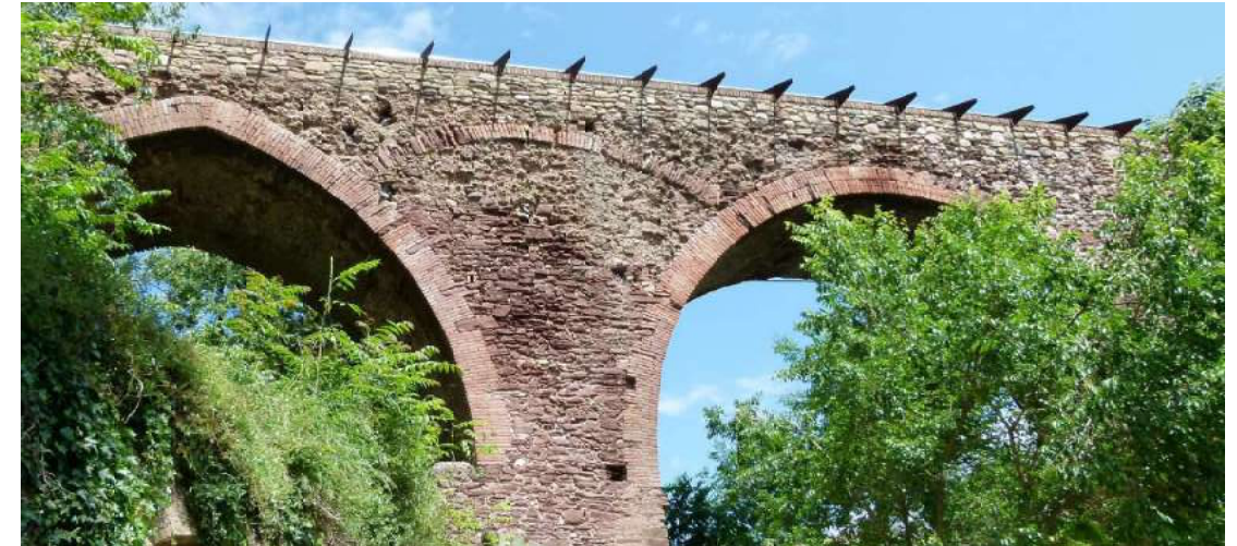
Figura 15: Parament Sud del pilar 1 amb visió dels arcs 1 i 2 (10/05/2017).
