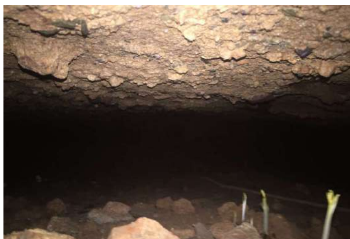
Figura 27: Cala 3: espai lliure entre l'intradós de l'arc i el reble (5/05/2017).
