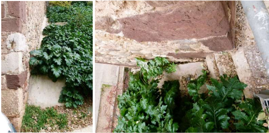
Figura 28: Cunetes existents a la base del parament Sud.
