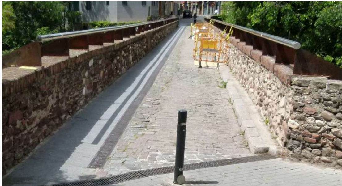
Figura 29: Ubicació a la plataforma del pont de les cales 4 i 5 (10/05/2017).
