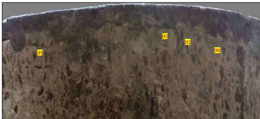
Figura 47 – Vista de detall de la fissura de l'arc 3 en el model fotogramètric elaborat el 2017.
