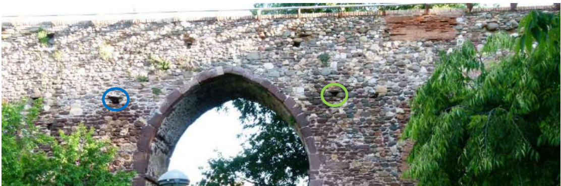
Figura 18: Parament Sud de l'arc 4 amb els dos nínxols on es va mesurar la fondària (24/04/2017).
