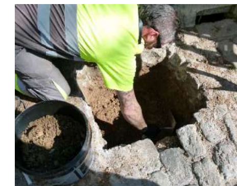
Figura 22: Excavació de la cala 1 damunt de l'arc 1 (24/04/2017).
