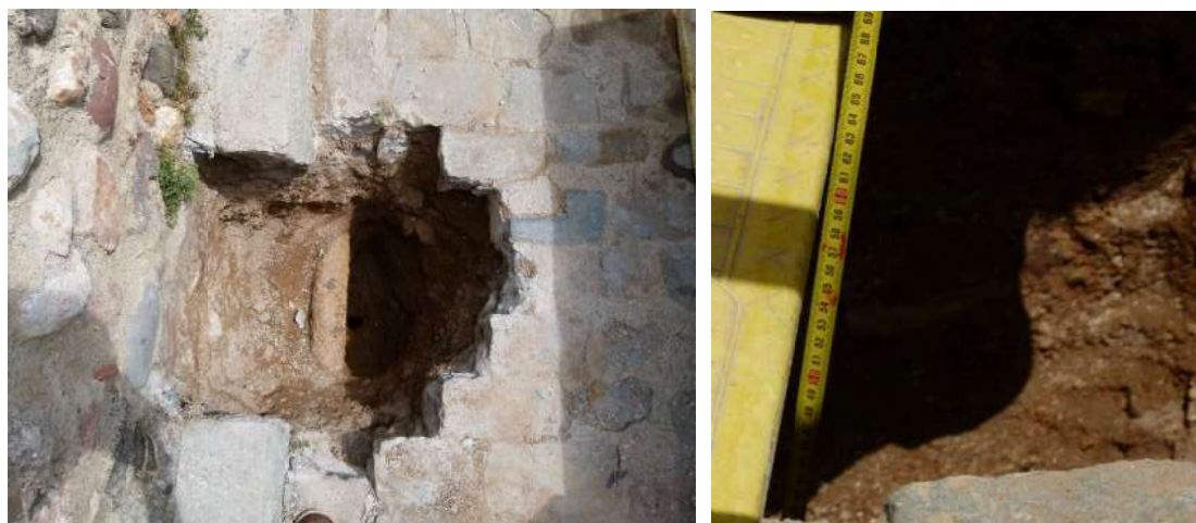
Figura 30: Cala 4: Vista de la cala i cota excavada (10/05/2017).
