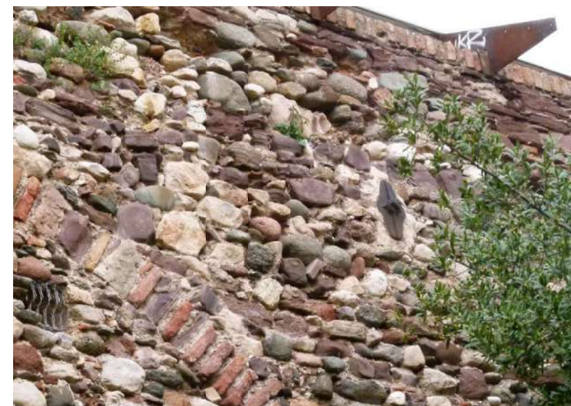
Figura 23: Fotografia del parament Sud amb tirant existent.
