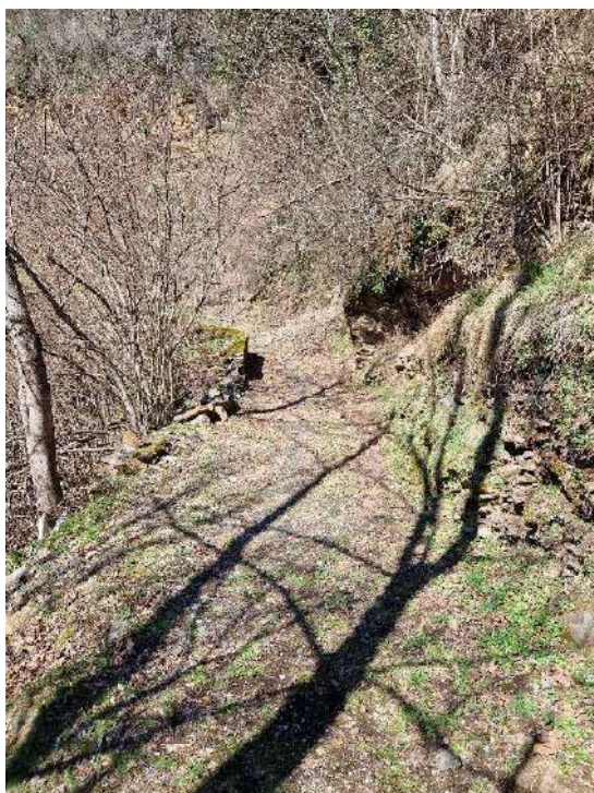
Imatge 2: El paviment és de terres, d'amplada variable entre 2 i 2,5 metres i en alguns punts l'amplada queda reduïda per l'acumulació de material. Petita palanca per vianants.
