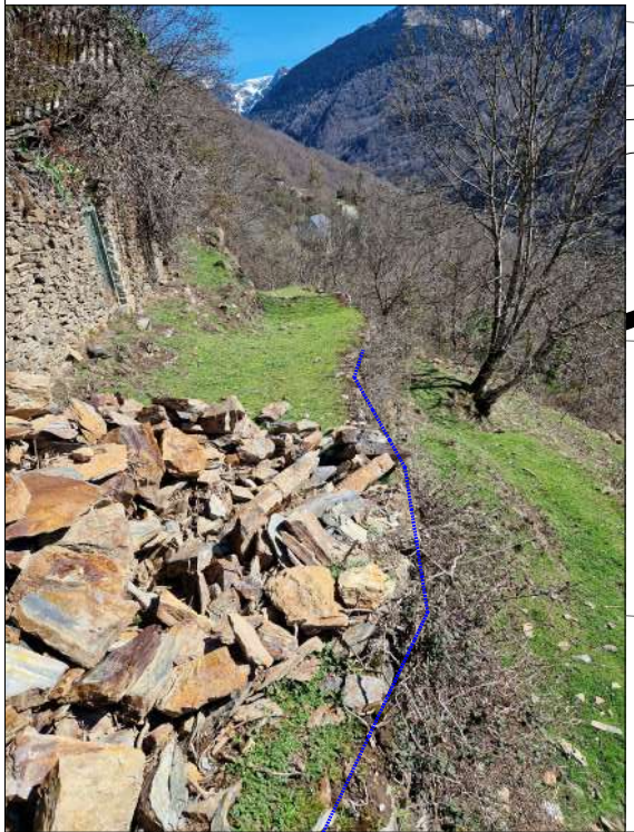
ACTUACIÓ 7: instal·lació de barana de fusta incada al terra sobre daus de formigó. 10m
