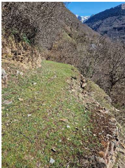
Imatge 4. Murs de pedra seca parcialment esfondrats. Camí completament cobert de runa.
