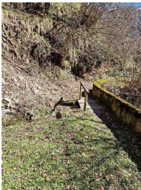
Imatge 2: El paviment és de terres, d'amplada variable entre 2 i 2,5 metres i en alguns punts l'amplada queda reduïda per l'acumulació de material. Petita palanca per vianants.
