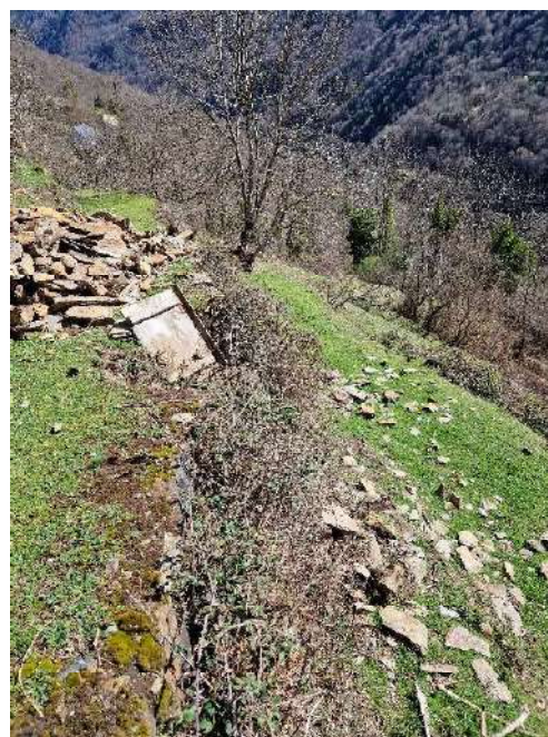
Imatge 4. Murs de pedra seca parcialment esfondrats. Camí completament cobert de runa.
