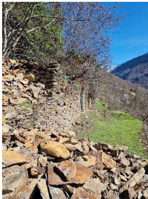
Imatge 3. Mur de pedra i morter enrunat. Runa ocupant el camí procedent de una era en estat de ruïna.
