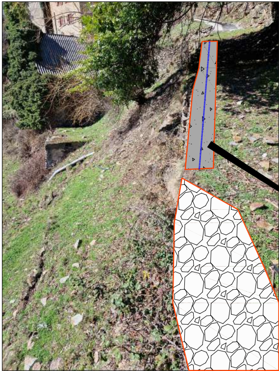
ACTUACIÓ 9: restauració de mur de pedra seca. 5x3m
