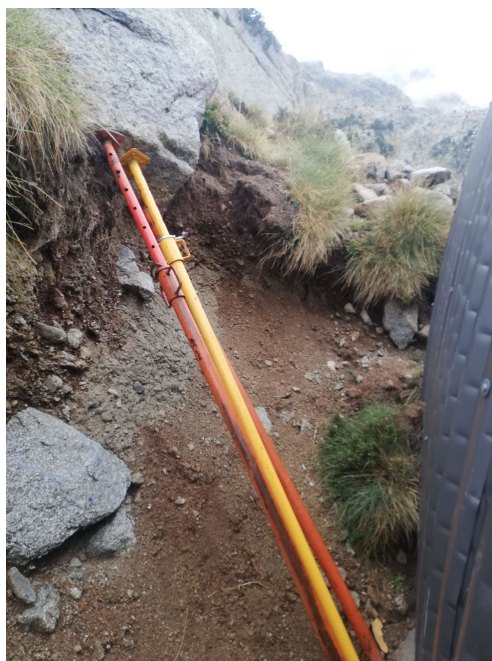
Pedra exterior amb perill de caiguda al refugi
