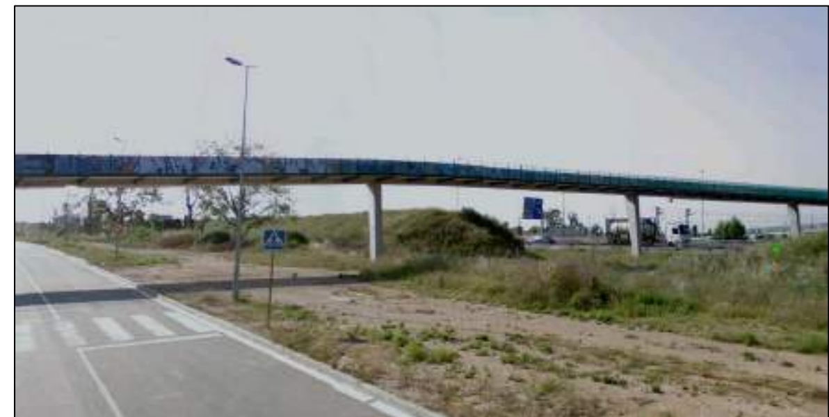
Figura 48. Passarel·la que creua el riu Llobregat al terme de Cornellà de Llobregat Font: elaboració pròpia
