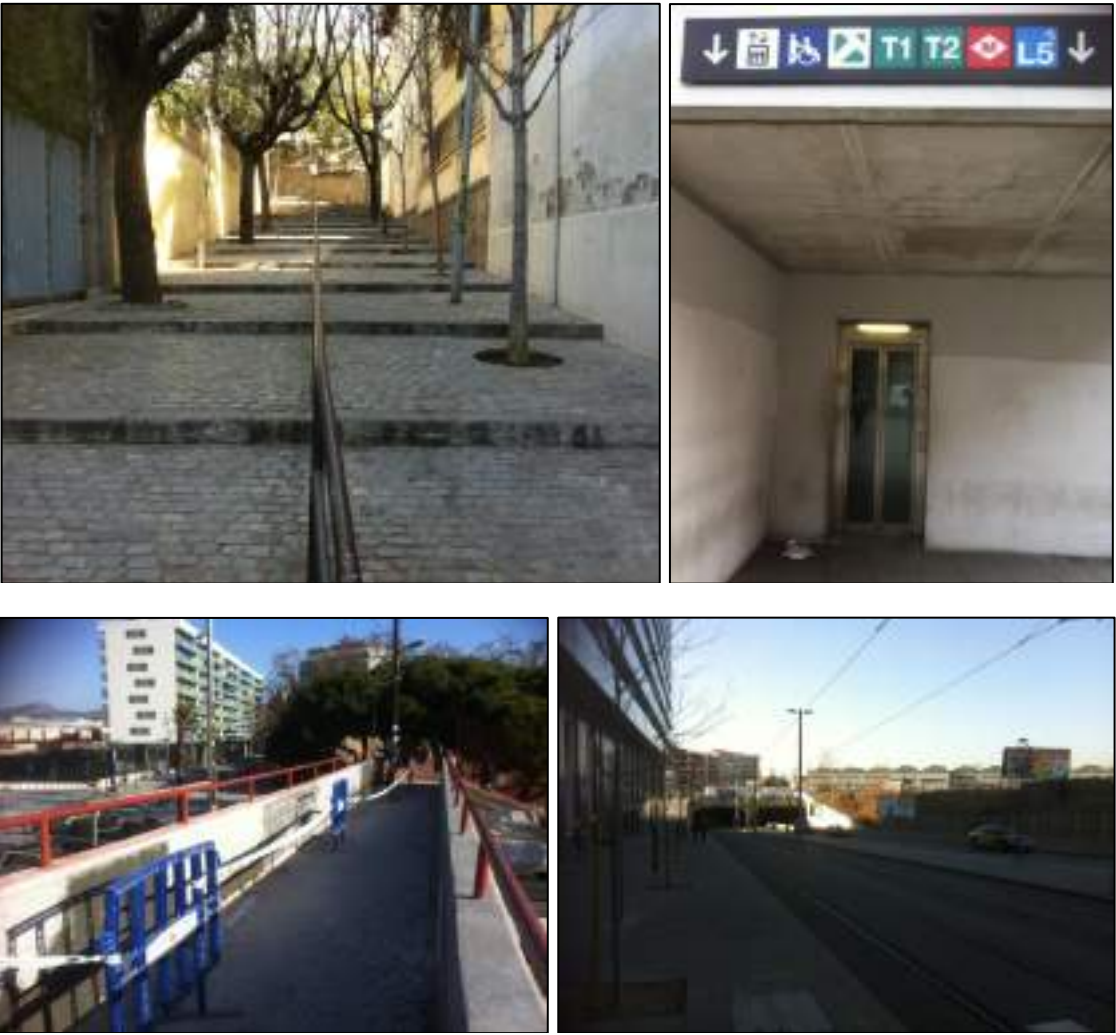
Figura 38. Imatges de les principals connexions que superen desnivells. Les escales del carrer de Miquel de Roncalí. Ascensor que connecta la parada de Metro i Tram de Cornellà Centre. Passarel·la a l'estació de Cornellà de Rodalies. Voreres amb pendent mig a la Ctra. d'Esplugues cap al pas soterrat de vies. Font: elaboració pròpia a partir del treball de camp
