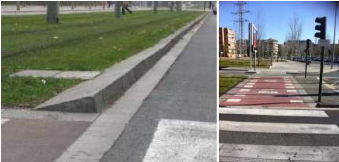
Figura 81. Arestes vivies separen el traçat del Tram i la calçada. Font: elaboració pròpia.
