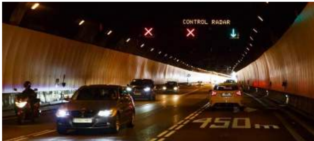
Figura 165 Exemple de carril reversible al túnel de Vallvidrera. Font: El Periódico
