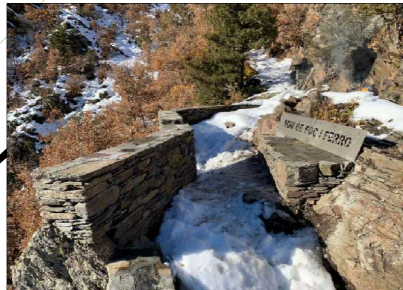
Detall-mostra de les parets de pedra per murs
