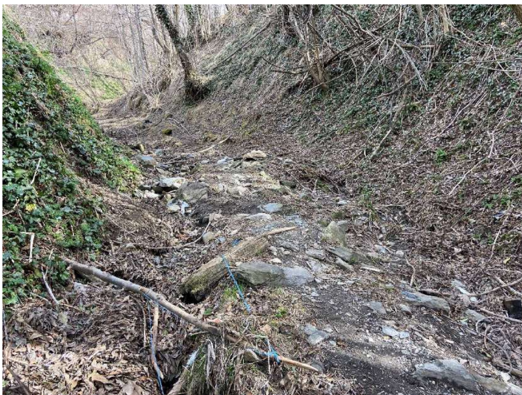
Imatge 3. Runa, restes vegetals colmatant la el torrent de Civís.
