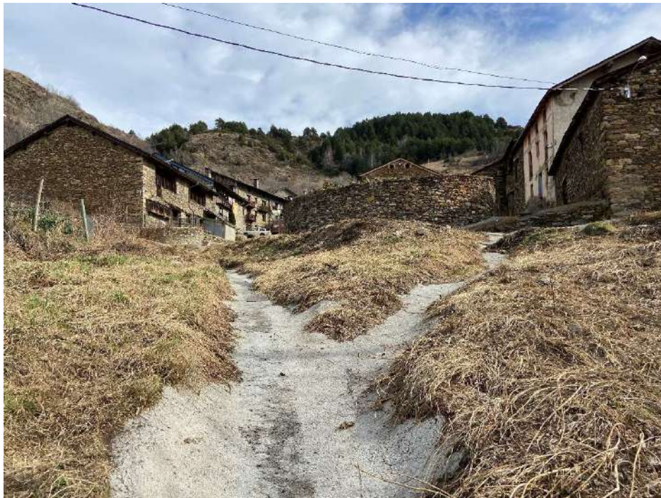
Imatge 4. Cunetes actuals que condueixen l'escorrentia del torrent cap a la seva llera natural.
