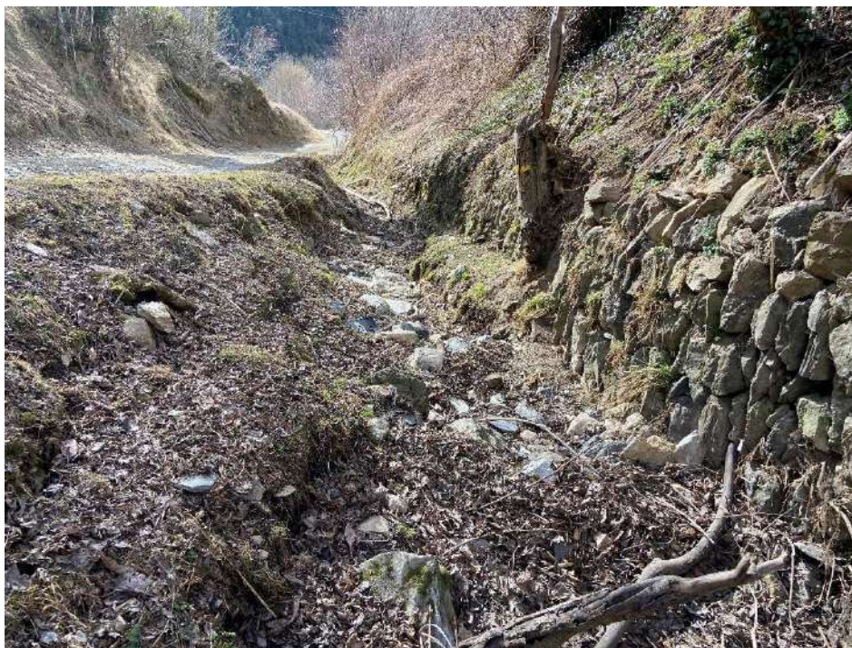
Imatge 7. Tram limitat per paret de pedra i amb la cuneta enrunada.
