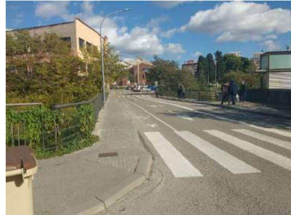
Fotografia núm. 11 – Vista general del carrer del cementiri Vell sobre el pont
