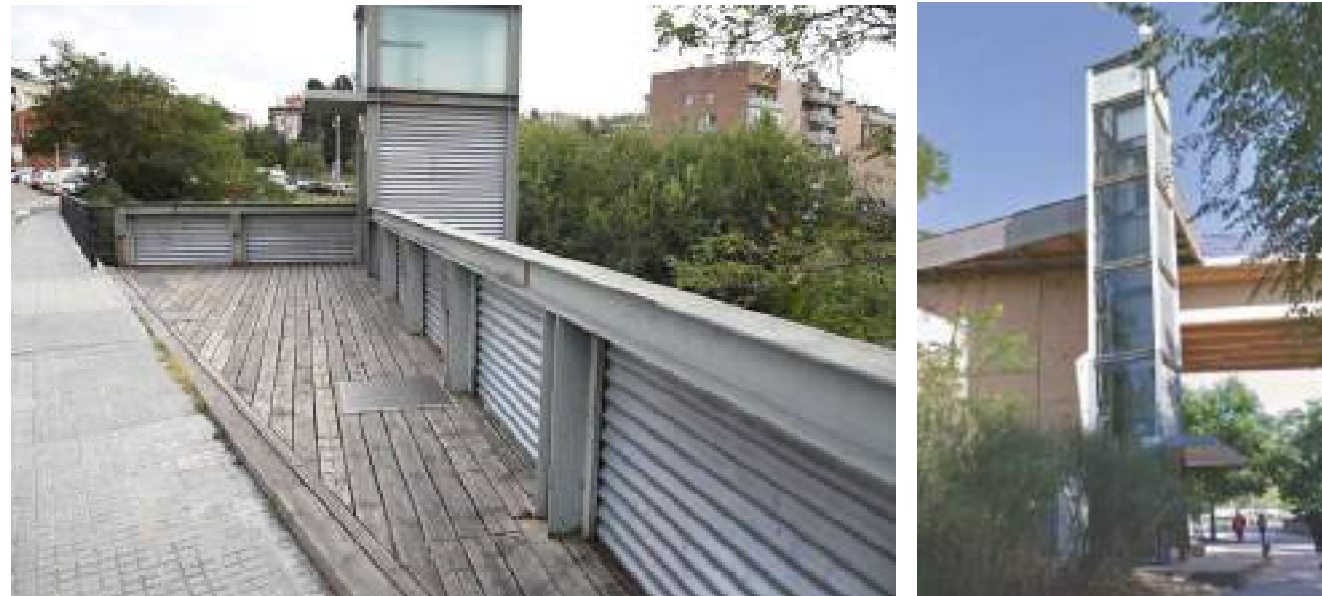
Imatges de l'estructura de suport de l'ascensor
