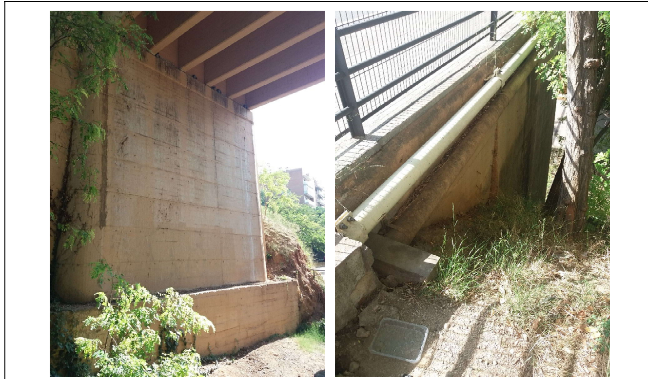
Fotografia núm. 7/8 – Estrep est. Parament frontal i aleta aigües amunt
