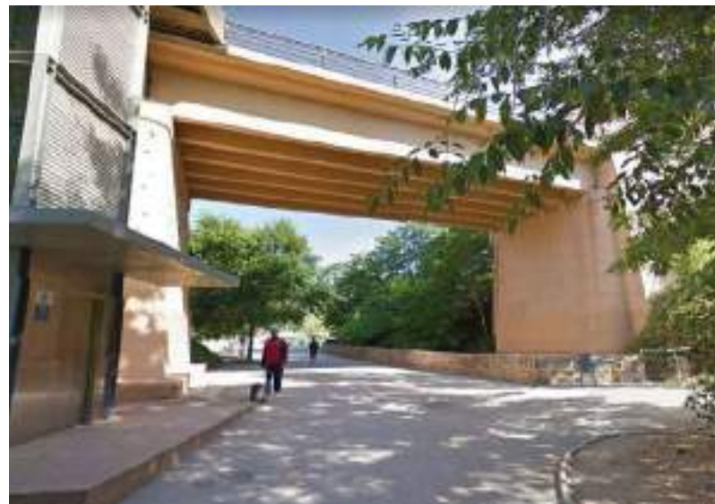
Fotografia del pont
