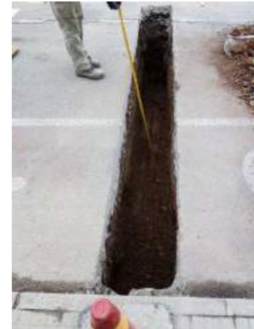
Rasa el calçada
