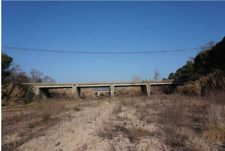
Imatge 2. Pont de la carretera C-35.
