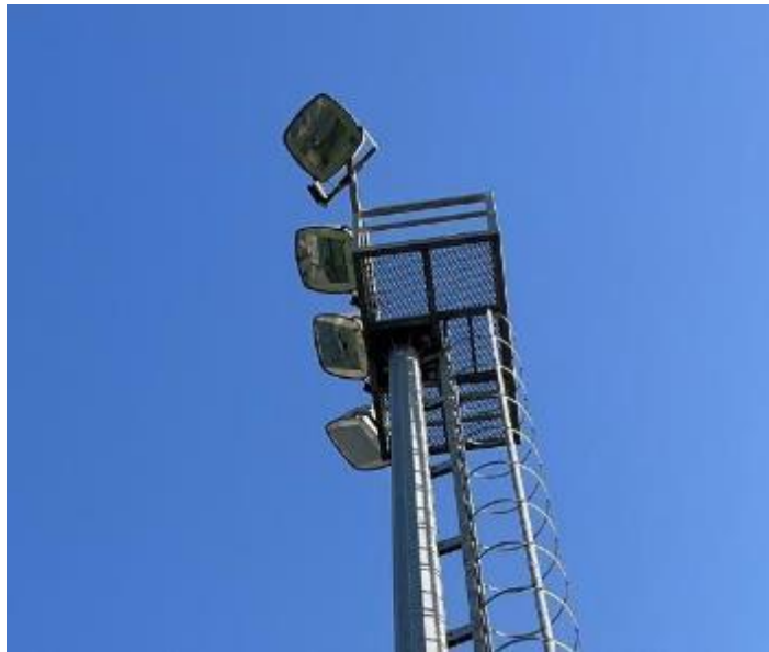
Figura 1 Torre campos de futbol existentes
