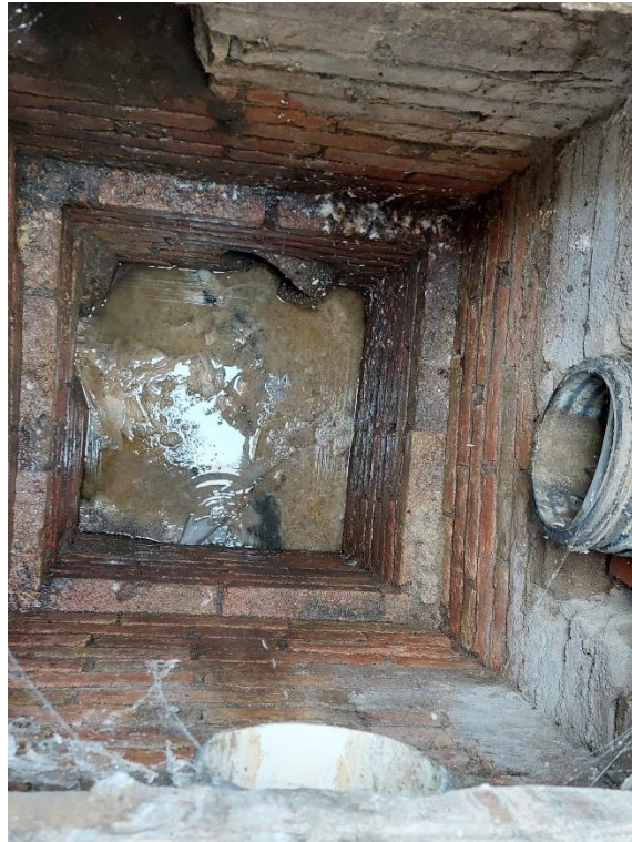
Fotografia de l'interior del pou
