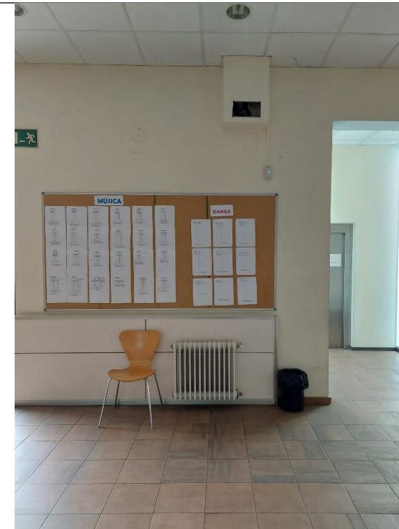
Fotografia de la zona on s'ubica la canalització vertical de la canalització d'aigües pluvials
