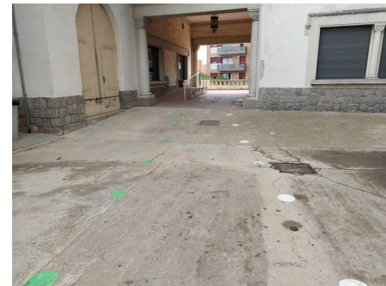
Fotografia d'ubicació del pou i la reixa del pati interior de l'edifici
