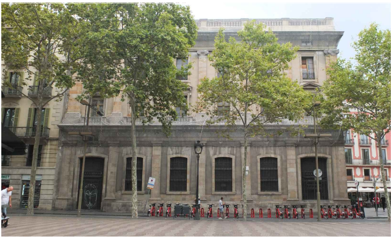
Vista general de la façana sud-oest. Basament, cos mig i coronament. Font: GAA 30/08/2021
