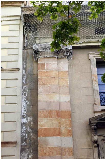
Pilastres toscanes de pedra en façana de planta baixa-altell. Font: GAA 04/08/2021
