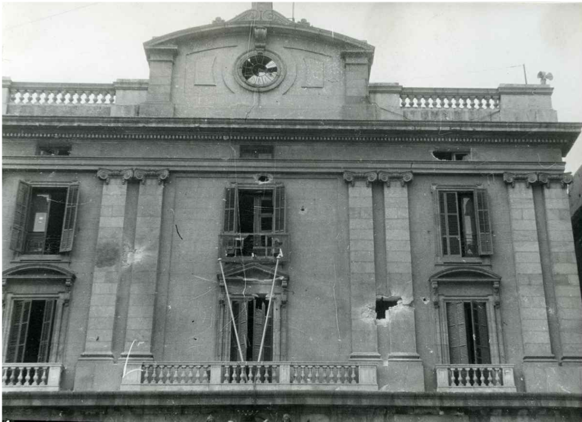
Fets del 6 d'octubre de l'any 1934. Façana principal del Banc de Barcelona. Font: Arxiu Històric de la Ciutat de Barcelona
