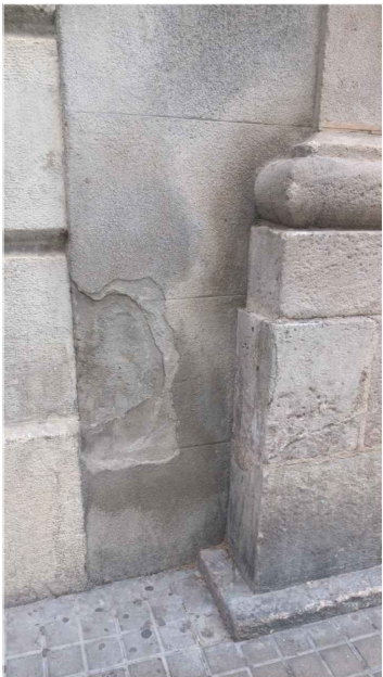
Pèrdua de l'arrebossat amb morter de ciment pòrtland. Font: GAA 03/08/2021
