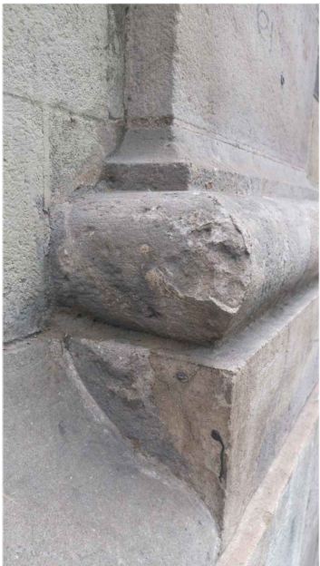
Erosió i pèrdua de secció del basament de pedra dels pilars. Font: GAA 03/08/2021
