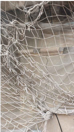
Esquerdes en el parament del capcer del rellotge. Font: GAA 04/08/2021
