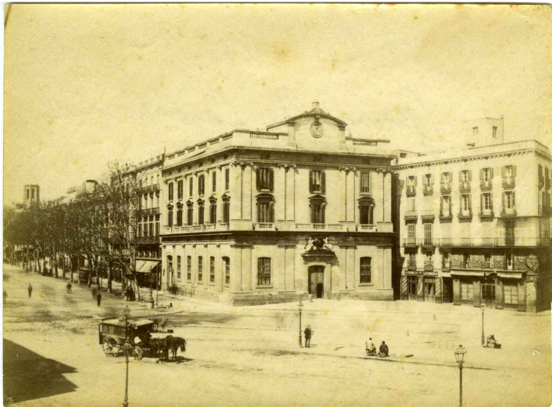
Vista general de l'edifici del Banc de Barcelona. Any 1885 Font: Arxiu Històric de la Ciutat de Barcelona
