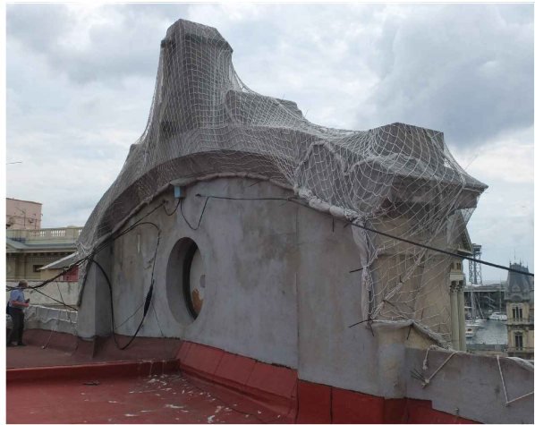
Capcer del rellotge vist des de la coberta de l'edifici. Font: GAA 30/08/2021
