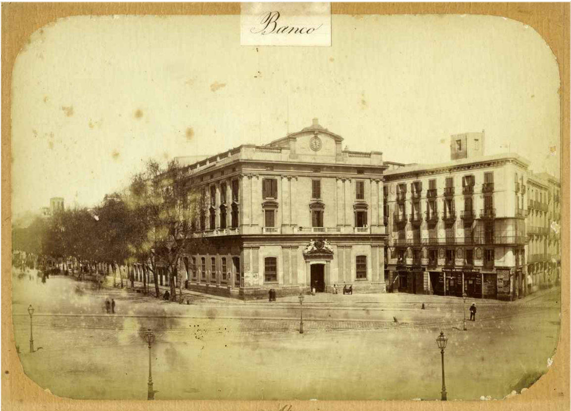
Vista general de l'edifici del Banc de Barcelona. Any 1874 Font: Arxiu Històric de la Ciutat de Barcelona
