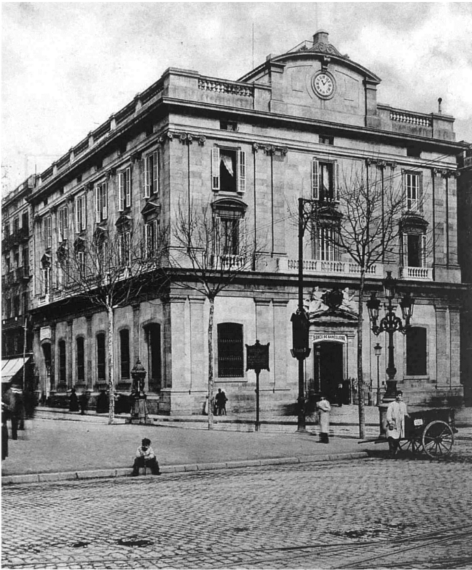
Vista general de l'edifici del Banc de Barcelona. Any 1894 Font: Arxiu Històric de la Ciutat de Barcelona
