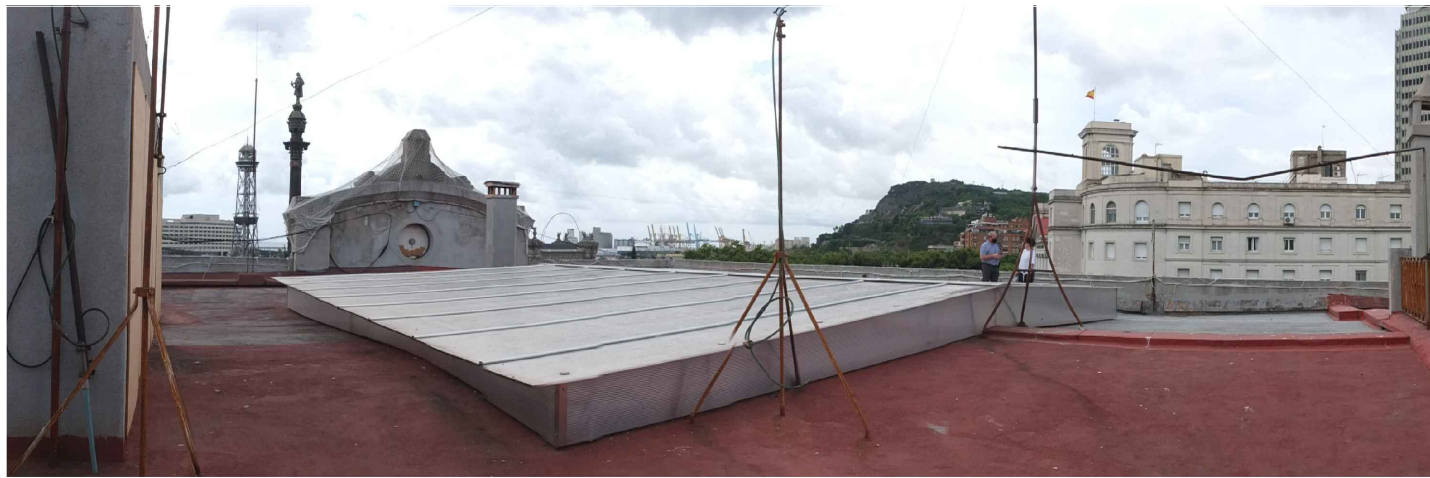
Vista general de la coberta plana de l'edifici. Coberta central que cobreix el pati interior. Font: GAA 04/08/2021
