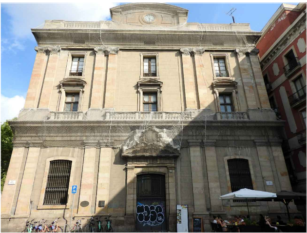
Vista general de la façana sud-est amb els elements de protecció. Plaça del Portal de la Pau. Font: GAA 30/08/2021
