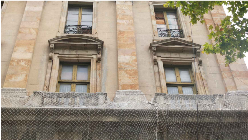
Cos mig de façana. Nivell planta primera i segona. Obertures de planta primera amb llindes i muntants de pedra motllurada i forntons que alternen formes triangulars i semicirculars. Font: GAA 30/08/2021
