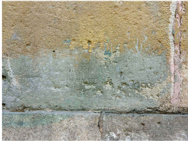
Ús de diferents materials disconformes duts a terme en diferents reparacions dels revestiments de les façanes. Font: GAA 03/08/2021
