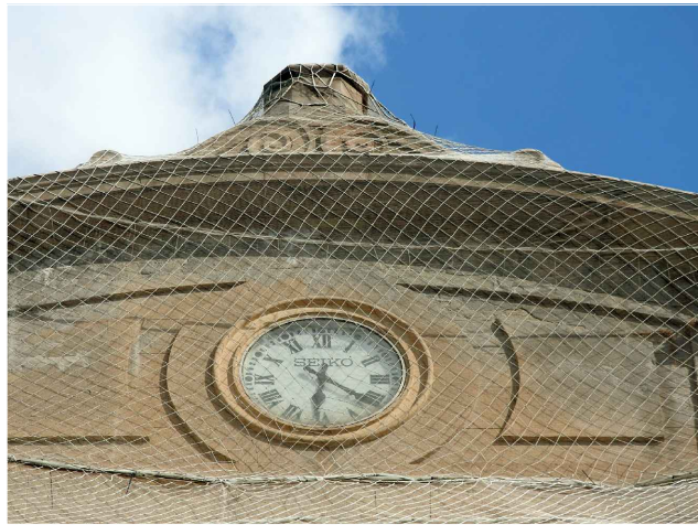
Xarxa de protecció en el capcer del rellotge per possibles despeniments de materials. Font: GAA 03/08/2021
