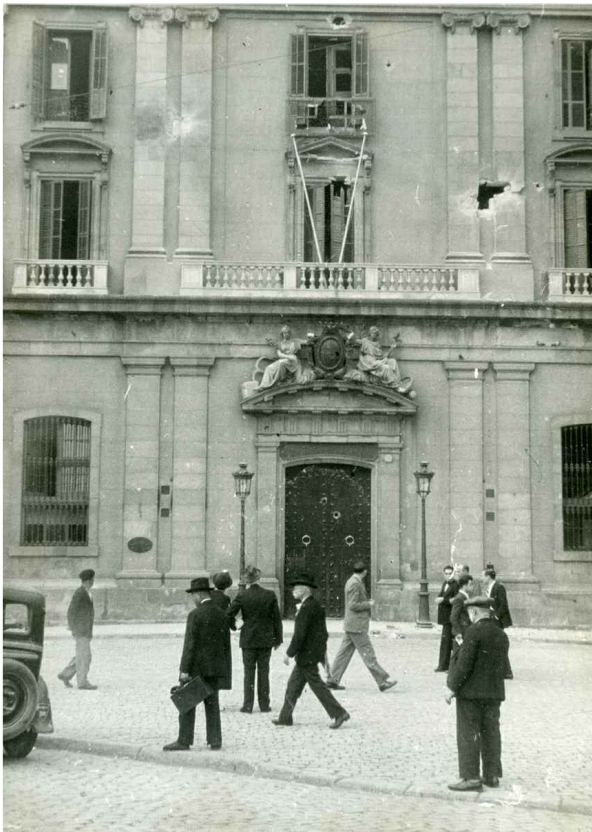
Fets del 6 d'octubre de l'any 1934. Façana principal del Banc de Barcelona. Font: Arxiu Històric de la Ciutat de Barcelona
