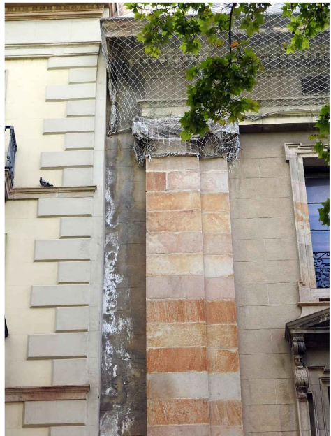
Concentració de sals en forma d'eflorescències en els paraments verticals. Font: GAA 03/08/2021
