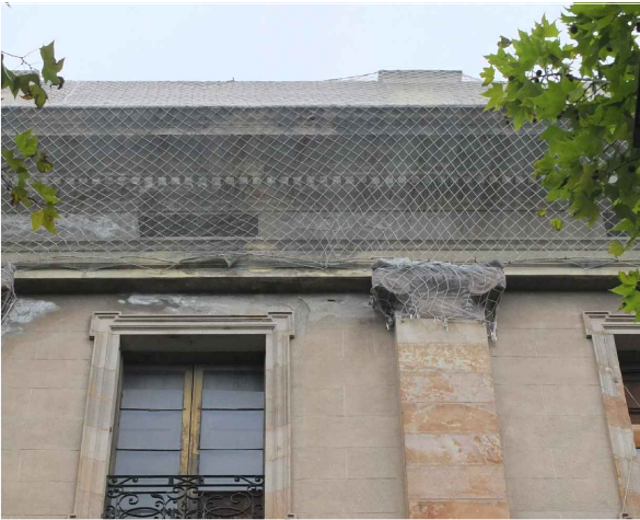
Coronament de façana. Planta tercera. Cornisa de coronament de pedra motllurada. Font: GAA 30/08/2021
