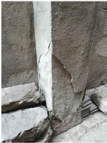
Pilars ceràmics de protecció de baixants. Font: GAA 04/08/2021
