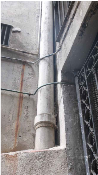
Protectors de baixants d'aigües pluvials i fecals. Baixants de fibrociment. Font: GAA 03/08/2021
