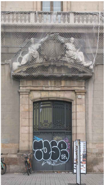
Portalada principal d'accés a l'edifici. Font: GAA 04/08/2021
