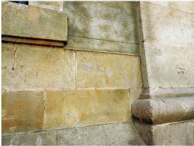
Alteració cromàtica de la pedra de Montjuïc del basament. Font: GAA 03/08/2021
