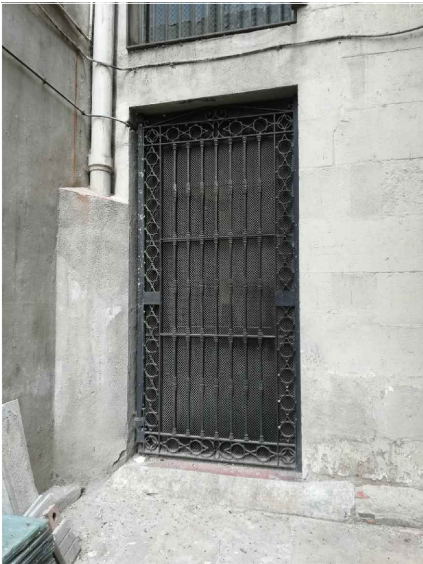
Oxidació de les reixes de forja de protecció de les obertures de façana. Font: GAA 03/08/2021
