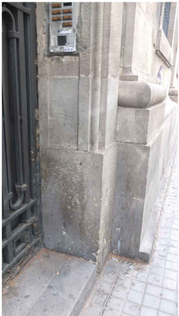
Oxidació de reixes de forja de la porta d'accés per restes d'orina. Font: GAA 03/08/2021
