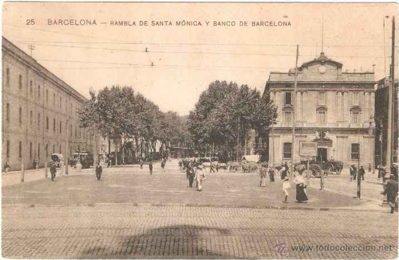
Vista general de l'edifici del Banc de Barcelona i Rambla de Santa Mònica. s. XIX Font: www.todocoleccion.net
