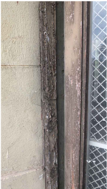
Fusteries de fusta de planta primera en mal estat. Font: GAA 04/08/2021
