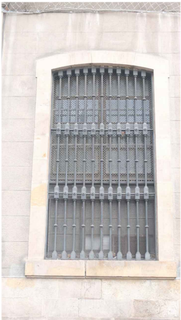
Finestral escarser amb muntants i dovelles de pedra i reixa de fosa. Font: GAA 04/08/2021
