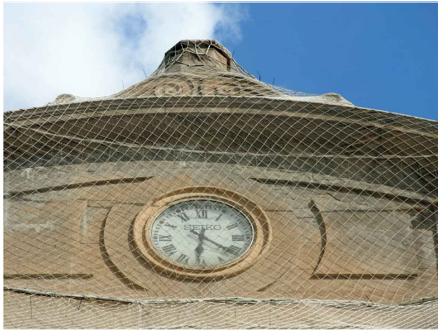
Detall del capcer del rellotge protegit amb reixes i malles. Font: GAA 30/08/2021
