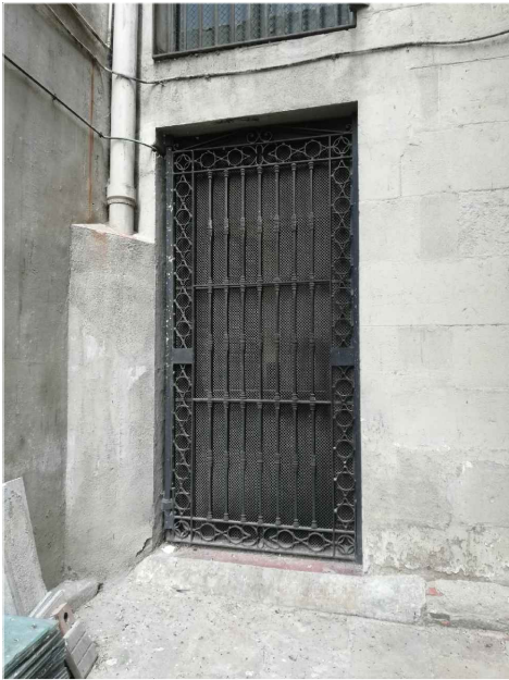
Porta d'accés a la planta baixa. Reixa de protecció. Font: GAA 30/08/2021
