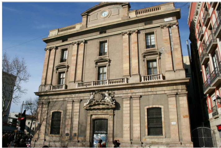
Vista general de la façana sud-est sense els elements de protecció. Plaça del Portal de la Pau. Font: Google
