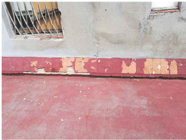
Paraments verticals de badalot d'escala i minvell perimetral ceràmic en mal estat de conservació. Font: GAA 04/08/2021
