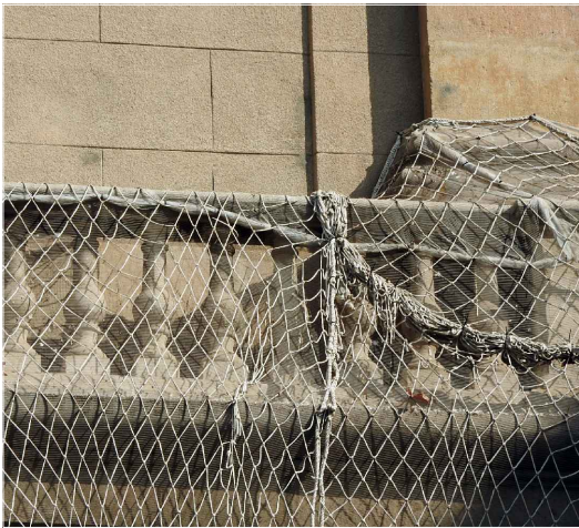
Xarxa de protecció en en la barana de balustres de planta primera per possibles despeniments de materials. Font: GAA 03/08/2021
