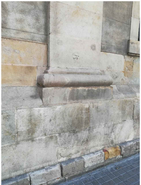
Alteració cromàtica de la pedra de Montjuïc del basament. Font: GAA 03/08/2021
