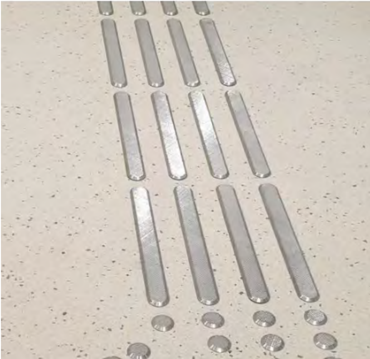
I 9.1_Paviment podotàctil d'encaminament
