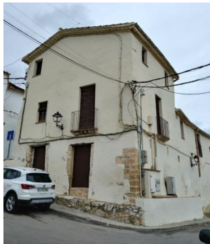
Façana de ponent. Destaca el volum, amb major alçada que la resta de l'edifici i amb el balcó, com element clar d'una intervenció del segle XIX.
