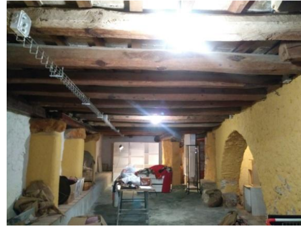
Interior de la planta semisotterrani. Amb el sostre de bigues de fusta i el lloc de les tines o cups.
