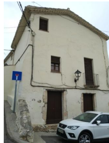
Façana de ponent. Destaca el volum, amb major alçada que la resta de l'edifici i amb el balcó, com element clar d'una intervenció del segle XIX.
