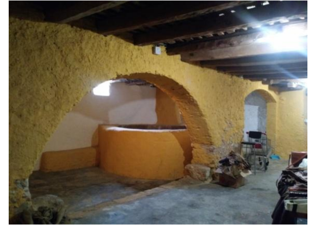
Interior de la planta semisotterrani. Amb el sostre de bigues de fusta i el lloc de les tines o cups.
