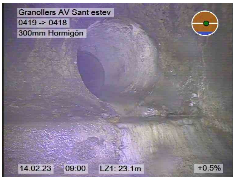
157.jpg, 00:01:57, 23.10m POZO FINAL CON 1 ACOMETIDA
