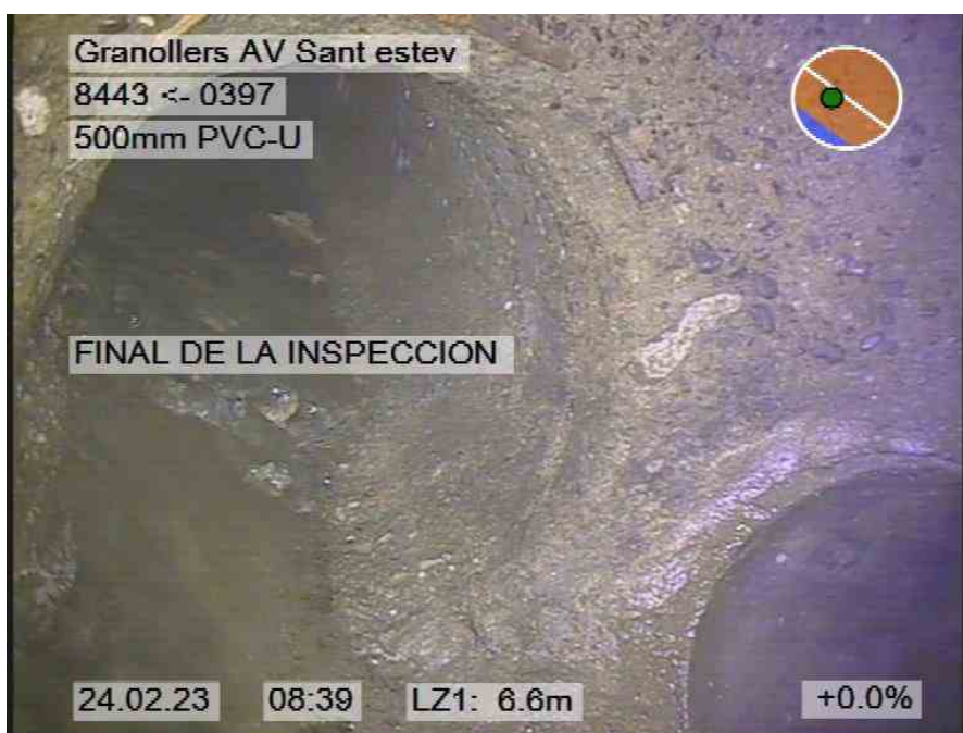
201.jpg, 00:01:59, 6.60m FINAL DE LA INSPECCION
