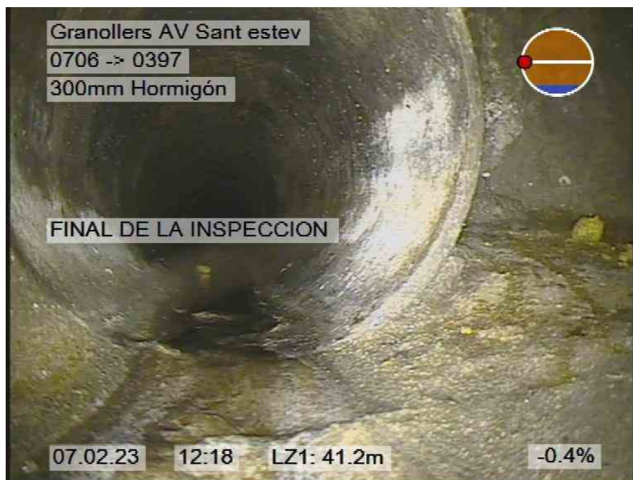
144.jpg, 00:04:47, 41.60m FINAL DE LA INSPECCION
