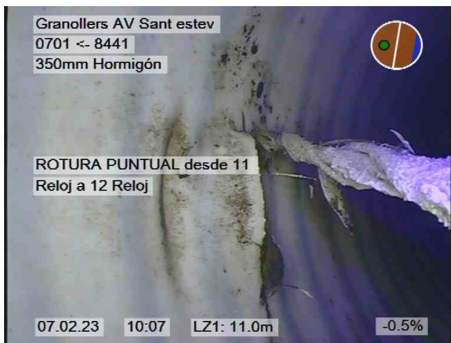
115.jpg, 00:02:04, 11.00m ROTURA PUNTUAL desde 11 Reloj a 12 Reloj
