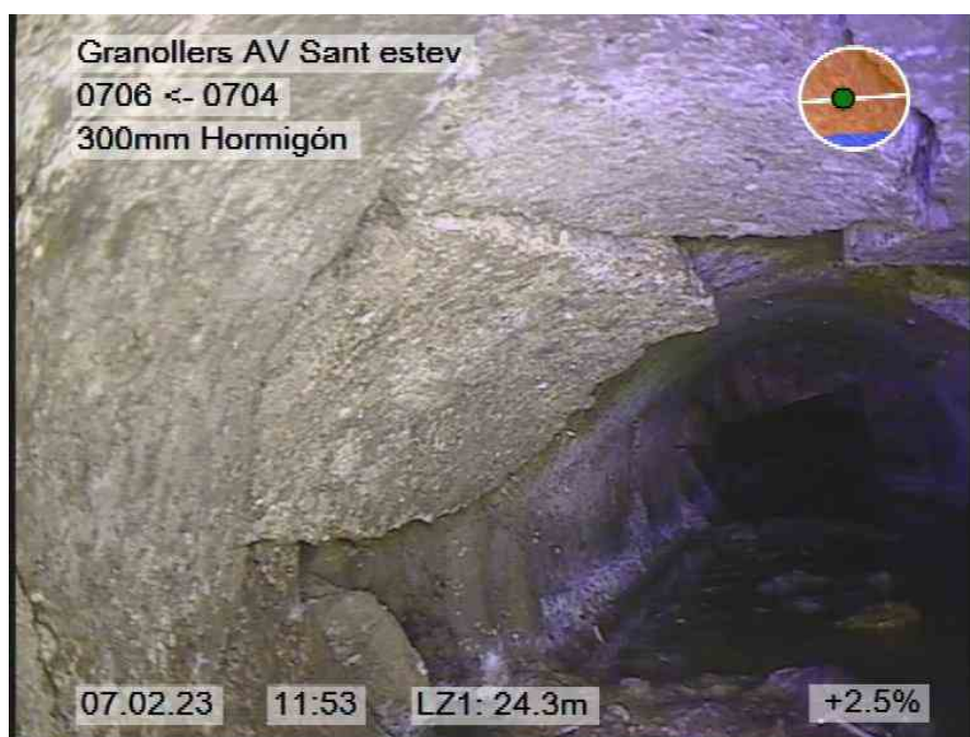
132.jpg, 00:02:41, 24.30m ROTURA PUNTUAL desde 8 Reloj a 4 Reloj
