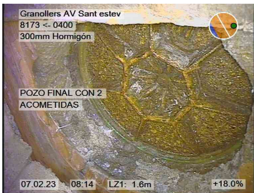
85.jpg, 00:00:27, 1.60m POZO FINAL CON 2 ACOMETIDAS
