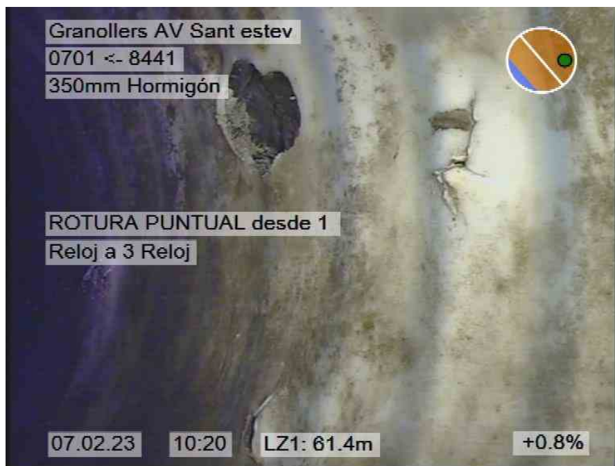
123.jpg, 00:14:34, 61.40m ROTURA PUNTUAL desde 1 Reloj a 3 Reloj
