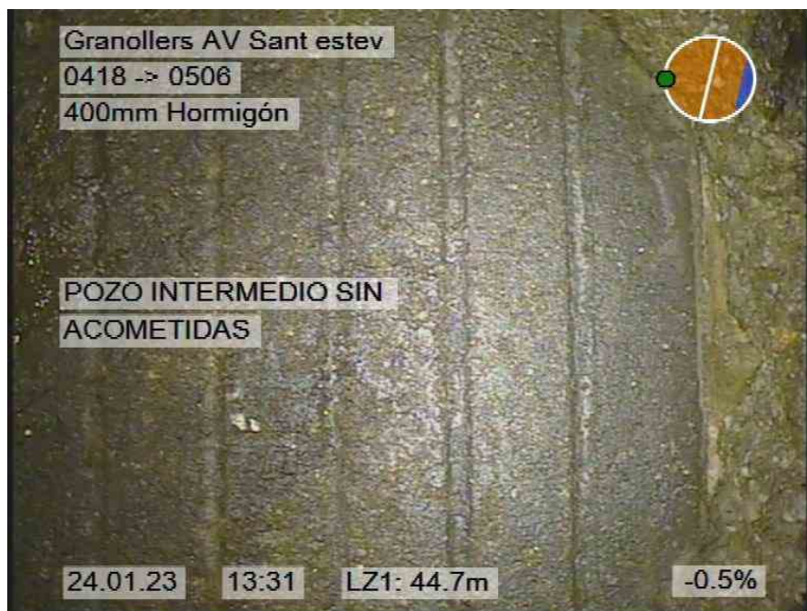
45.jpg, 00:03:38, 44.70m POZO INTERMEDIO SIN ACOMETIDAS
