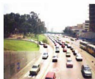
NIVELL DE SERVEI F
