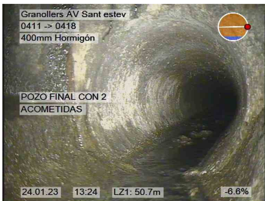
35.jpg, 00:04:14, 50.70m POZO FINAL CON 2 ACOMETIDAS
