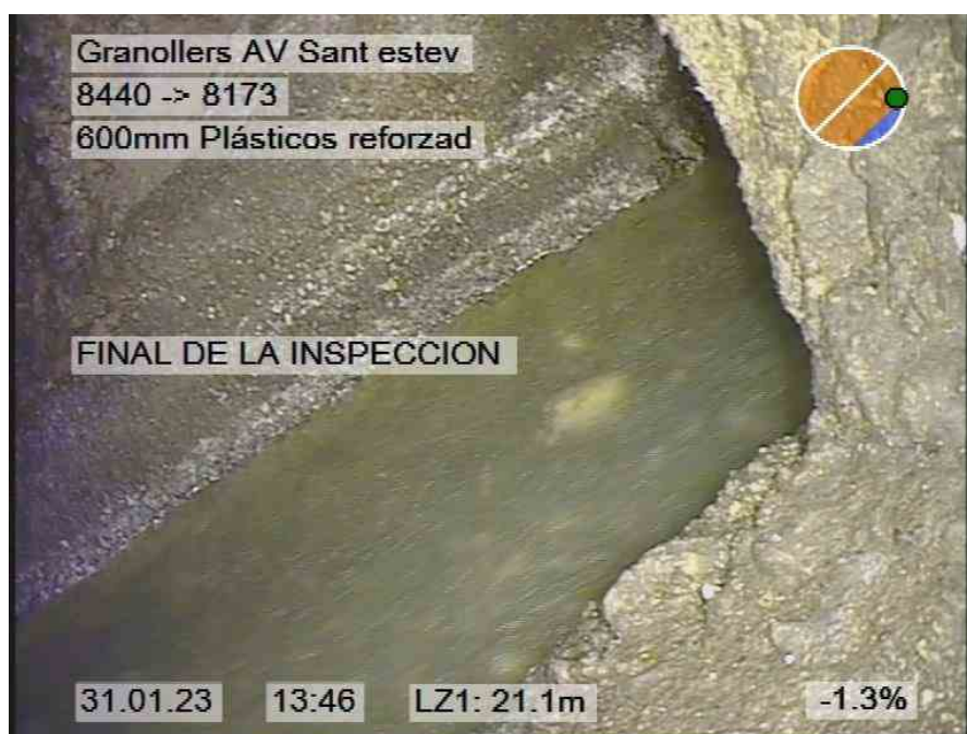
64.jpg, 00:02:22, 21.10m FINAL DE LA INSPECCION
