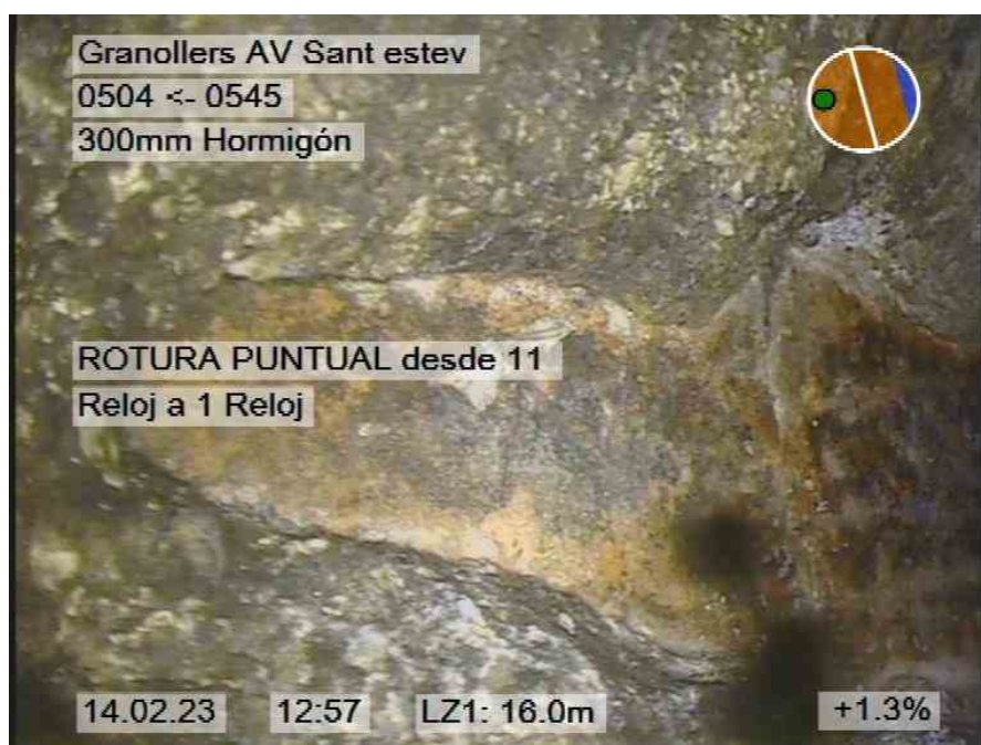
181.jpg, 00:02:27, 16.00m ROTURA PUNTUAL desde 11 Reloj a 1 Reloj
