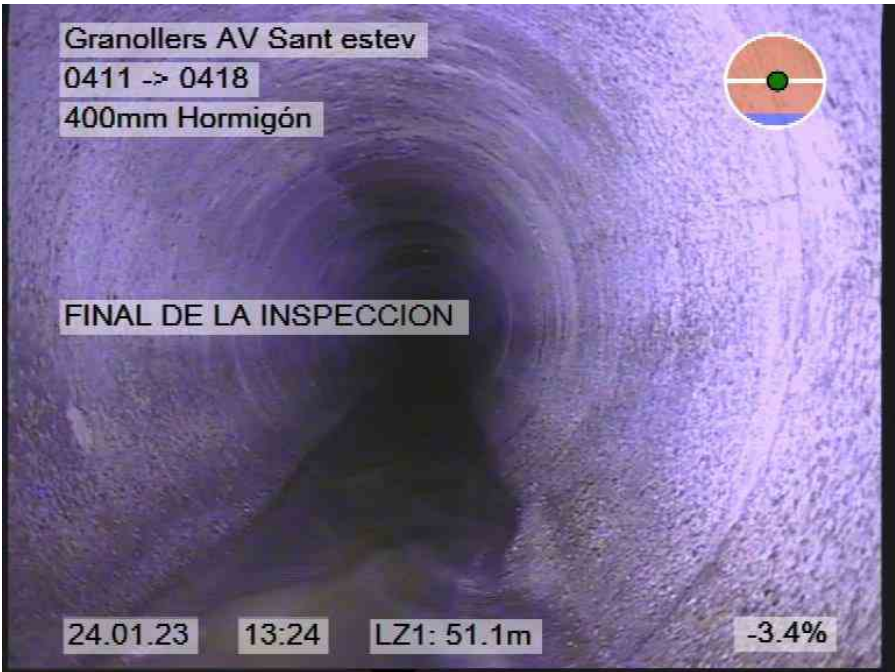
37.jpg, 00:04:31, 51.10m FINAL DE LA INSPECCION
