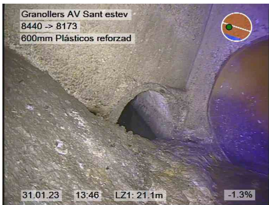
63.jpg, 00:01:55, 21.10m POZO FINAL CON 2 ACOMETIDAS
