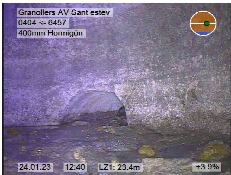
7.jpg, 00:02:53, 23.40m POZO FINAL CON 2 ACOMETIDAS
