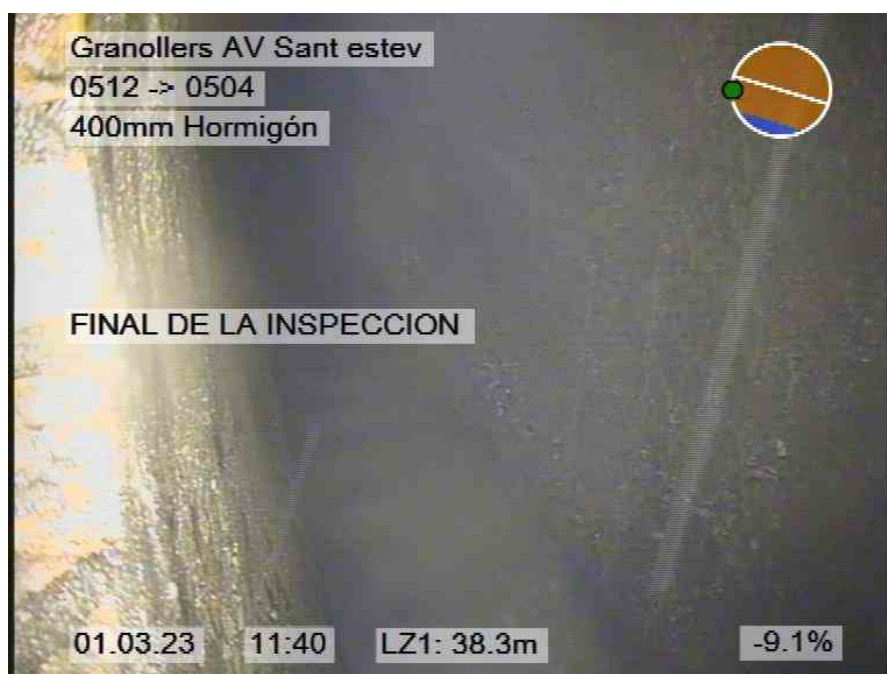
232.jpg, 00:04:35, 38.30m FINAL DE LA INSPECCION
