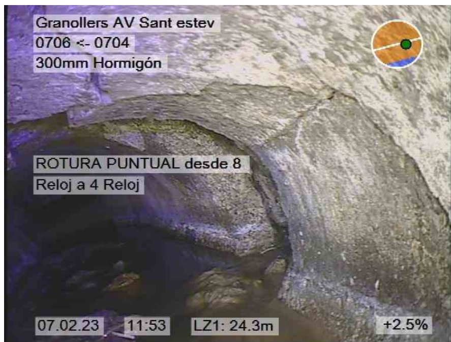
131.jpg, 00:02:41, 24.30m ROTURA PUNTUAL desde 8 Reloj a 4 Reloj
