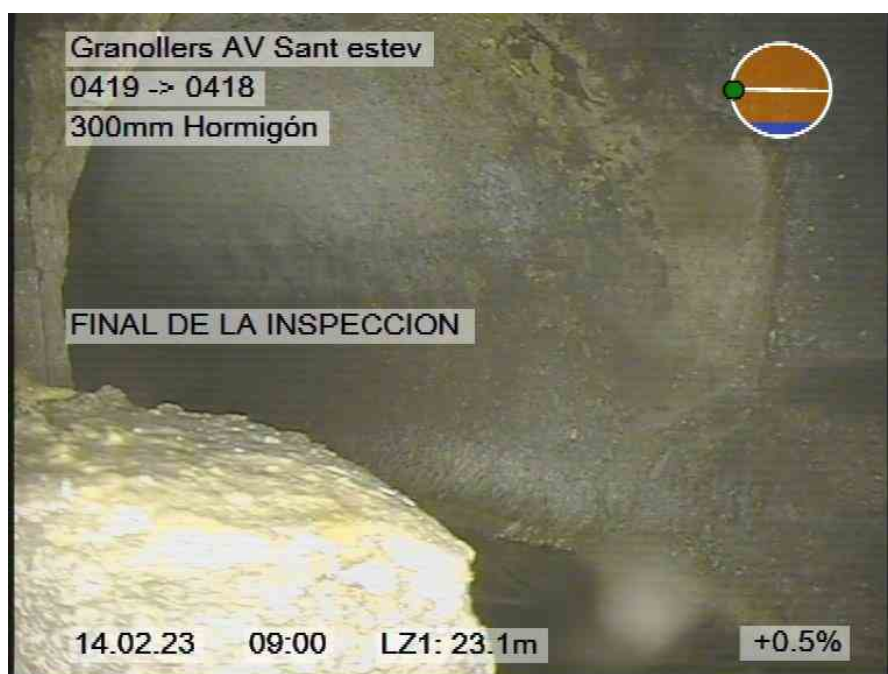
158.jpg, 00:02:08, 23.10m FINAL DE LA INSPECCION
