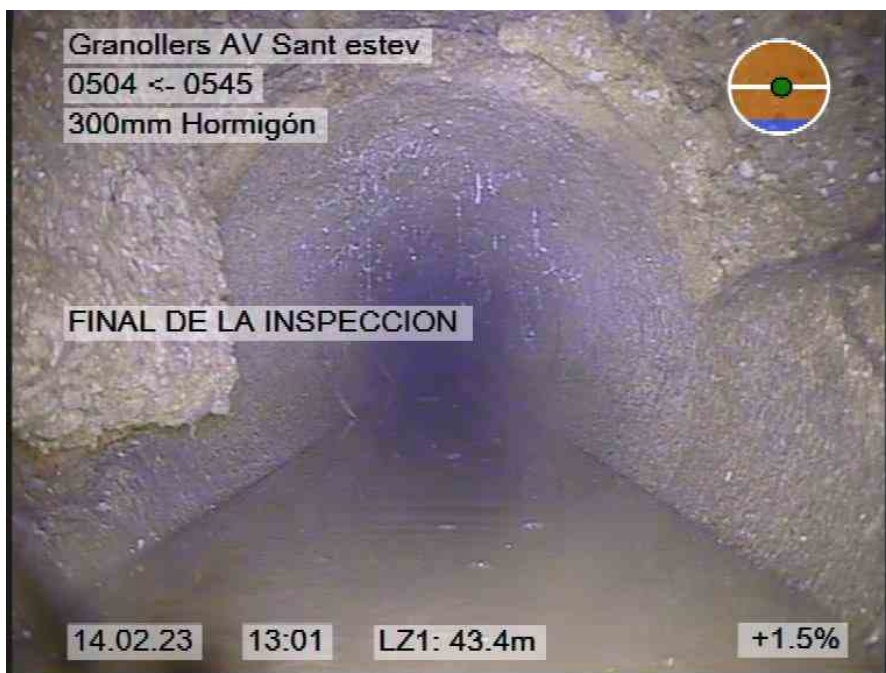
188.jpg, 00:05:41, 43.40m FINAL DE LA INSPECCION
