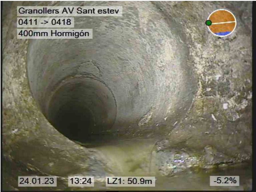
36.jpg, 00:04:14, 50.70m POZO FINAL CON 2 ACOMETIDAS
