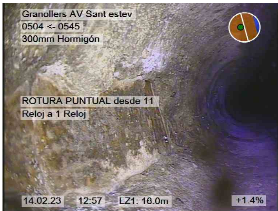
182.jpg, 00:02:27, 16.00m ROTURA PUNTUAL desde 11 Reloj a 1 Reloj
