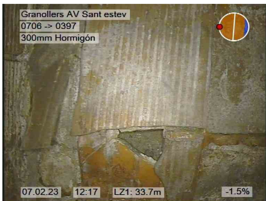
140.jpg, 00:03:03, 33.70m ROTURA PUNTUAL desde 11 Reloj a 1 Reloj
