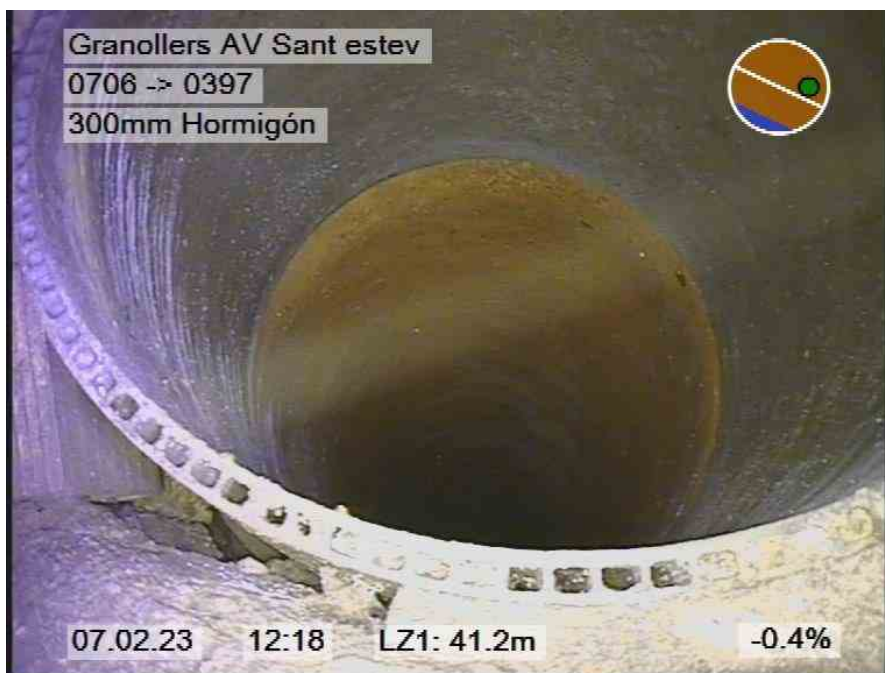
142.jpg, 00:04:05, 41.20m POZO FINAL CON 3 ACOMETIDAS
