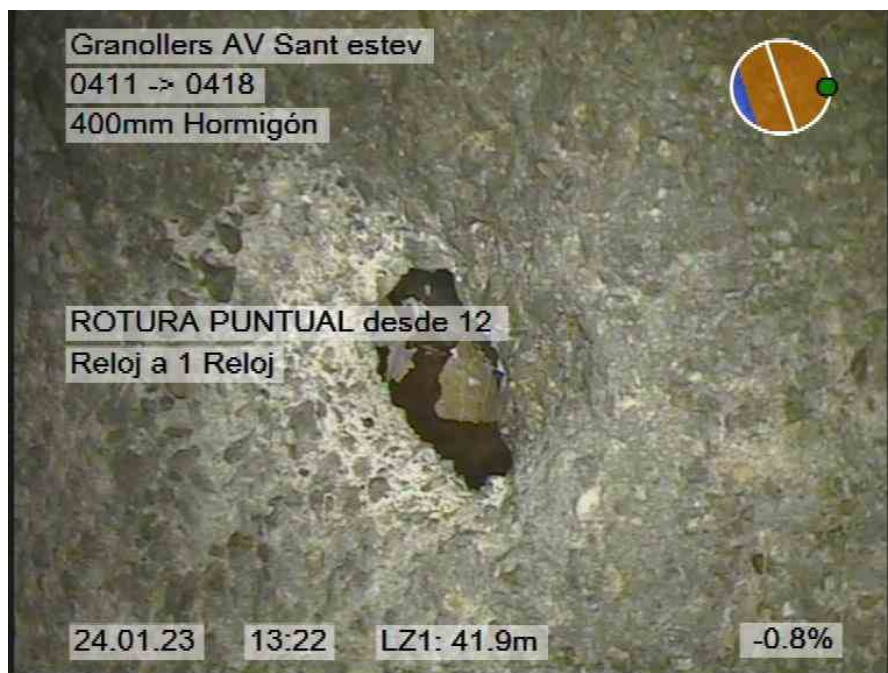
32.jpg, 00:03:03, 41.90m ROTURA PUNTUAL desde 12 Reloj a 1 Reloj
