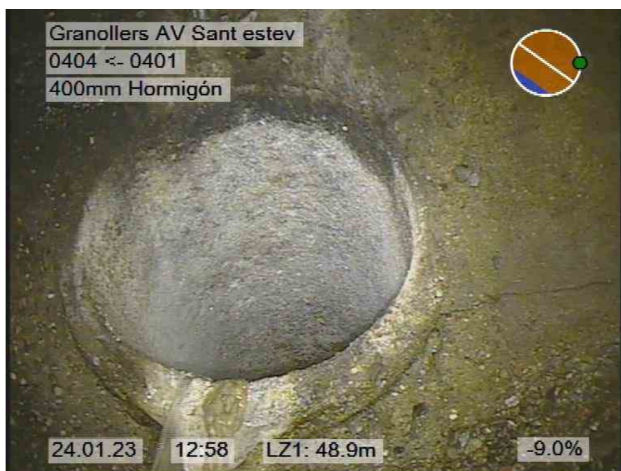
19.jpg, 00:04:50, 48.90m POZO FINAL CON 1 ACOMETIDA
