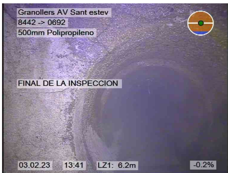
77.jpg, 00:01:09, 6.20m FINAL DE LA INSPECCION
