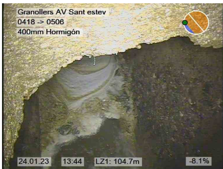
52.jpg, 00:10:23, 104.70m POZO FINAL CON 2 ACOMETIDAS
