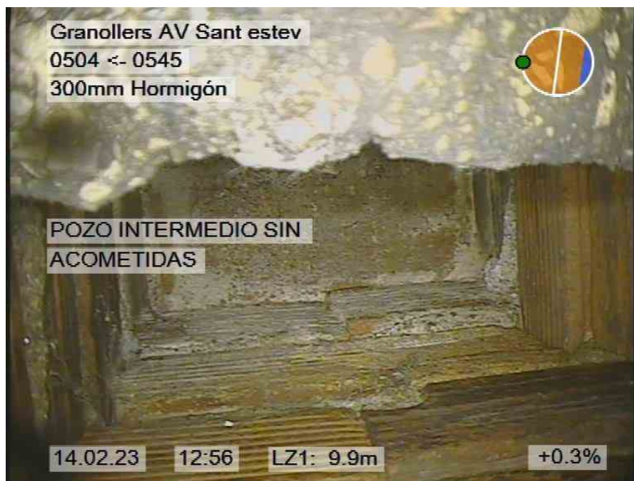
178.jpg, 00:01:35, 9.90m POZO INTERMEDIO SIN ACOMETIDAS
