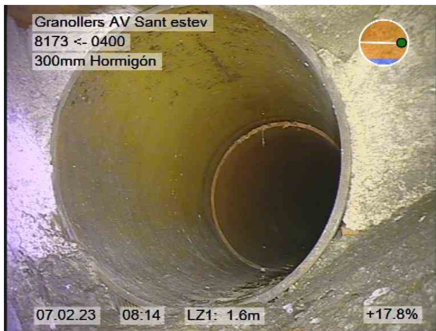
86.jpg, 00:00:27, 1.60m POZO FINAL CON 2 ACOMETIDAS
