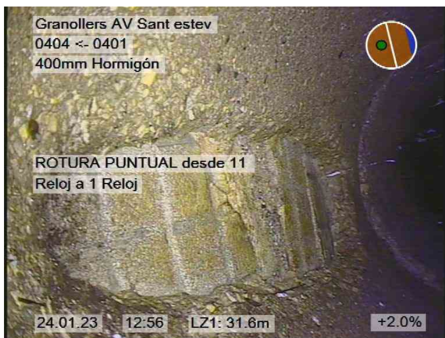
15.jpg, 00:03:08, 31.60m ROTURA PUNTUAL desde 11 Reloj a 1 Reloj
