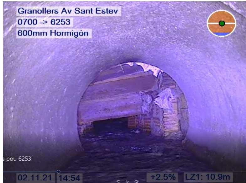
Figura 4: Inspecció de CCTV, imatge des del pou 700 aigües abaix en direcció al pou 6253
