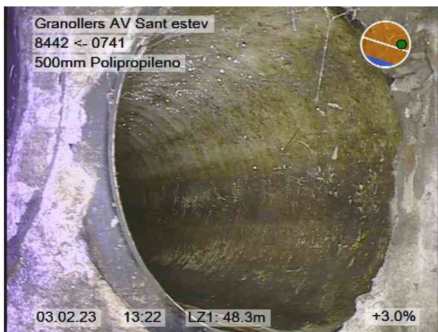
73.jpg, 00:06:54, 48.30m FINAL DE LA INSPECCION
