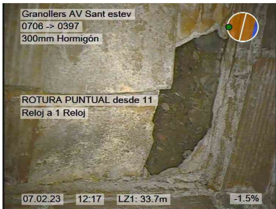
139.jpg, 00:03:03, 33.70m ROTURA PUNTUAL desde 11 Reloj a 1 Reloj
