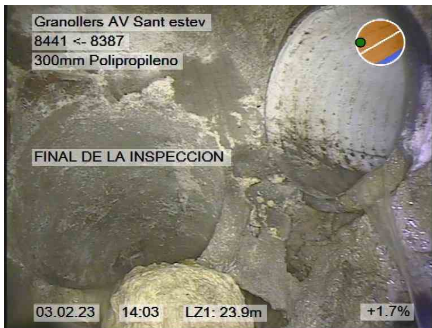
83.jpg, 00:02:13, 23.90m FINAL DE LA INSPECCION
