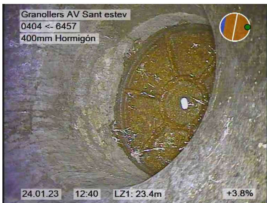
9.jpg, 00:03:01, 23.40m FINAL DE LA INSPECCION
