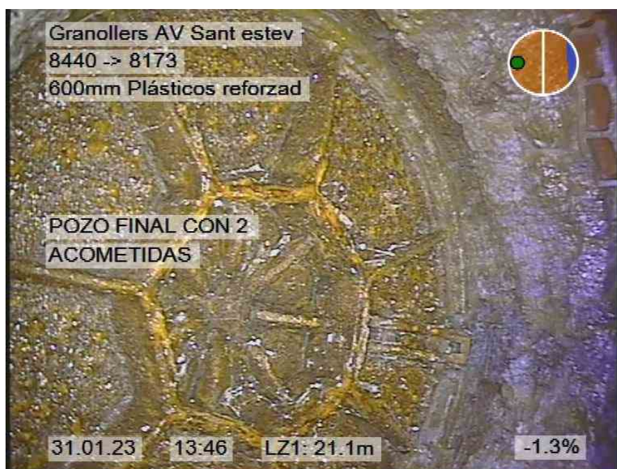
62.jpg, 00:01:55, 21.10m POZO FINAL CON 2 ACOMETIDAS
