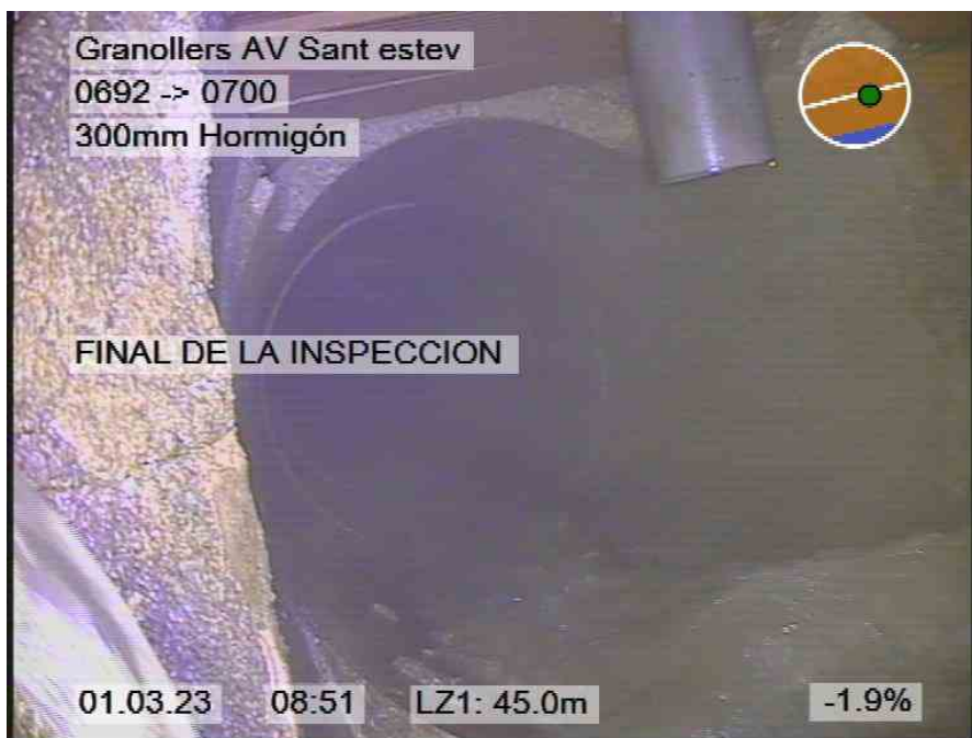
218.jpg, 00:12:06, 45.00m FINAL DE LA INSPECCION
