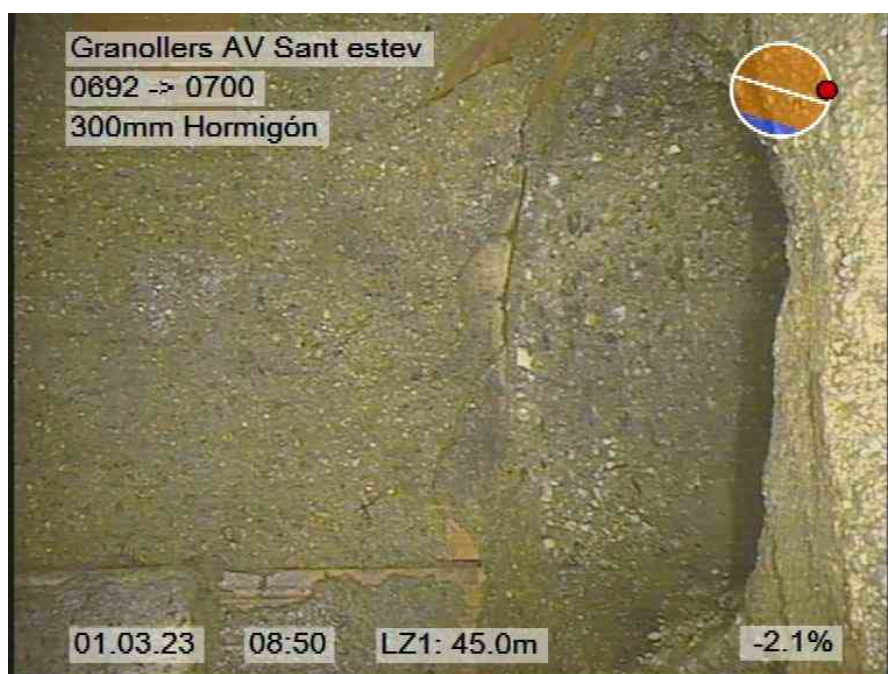
217.jpg, 00:11:37, 45.00m POZO FINAL CON 2 ACOMETIDAS
