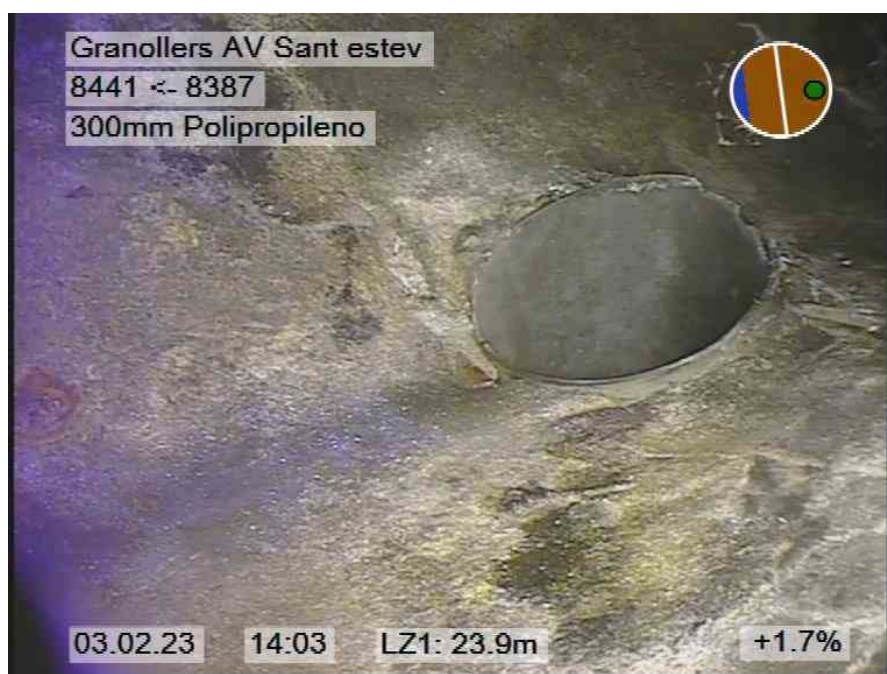
82.jpg, 00:01:56, 23.90m POZO FINAL CON 3 ACOMETIDAS
