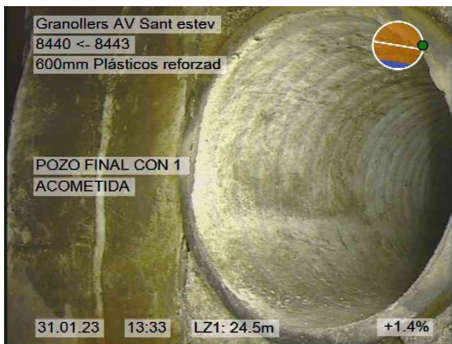
57.jpg, 00:01:12, 24.50m POZO FINAL CON 1 ACOMETIDA
