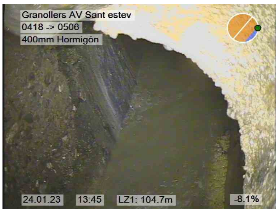
54.jpg, 00:10:43, 104.70m FINAL DE LA INSPECCION
