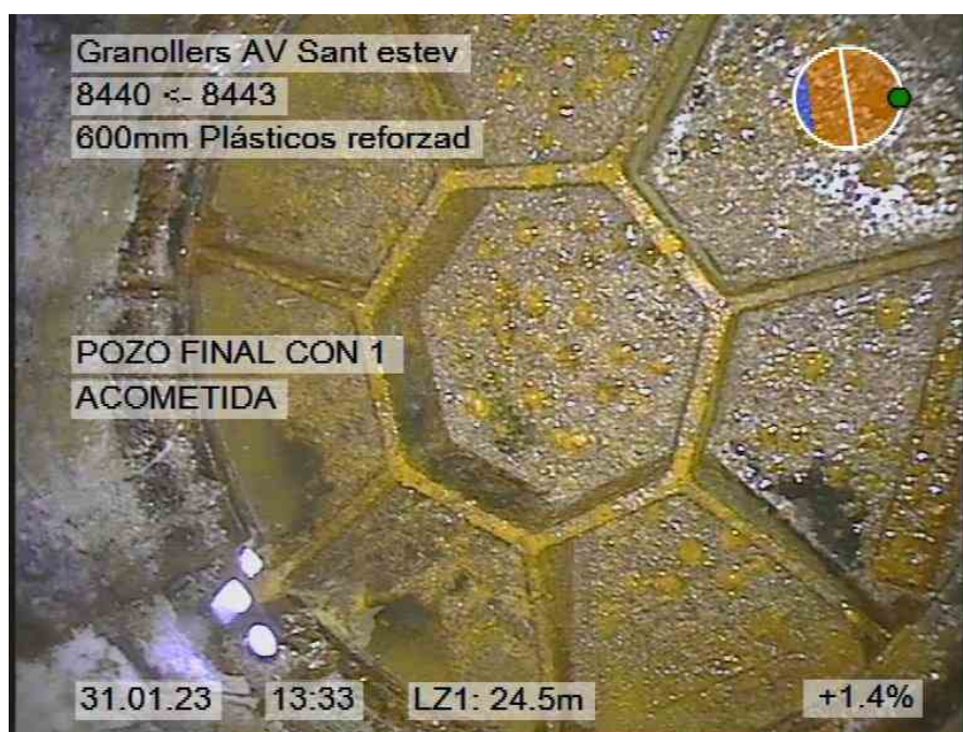
56.jpg, 00:01:12, 24.50m POZO FINAL CON 1 ACOMETIDA
