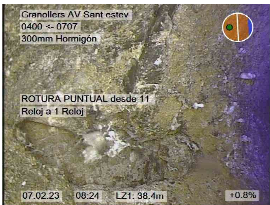
100.jpg, 00:05:29, 38.40m ROTURA PUNTUAL desde 11 Reloj a 1 Reloj
