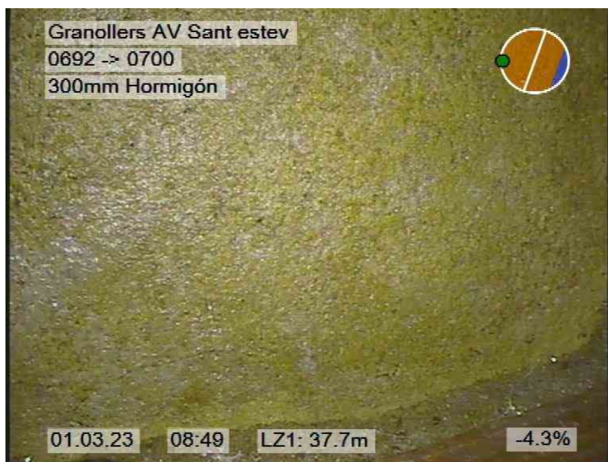
214.jpg, 00:10:06, 37.70m POZO INTERMEDIO CON 1 ACOMETIDA
