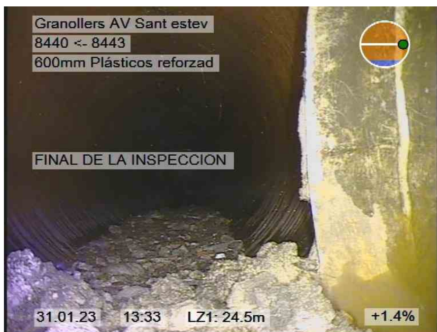
58.jpg, 00:01:21, 24.50m FINAL DE LA INSPECCION
