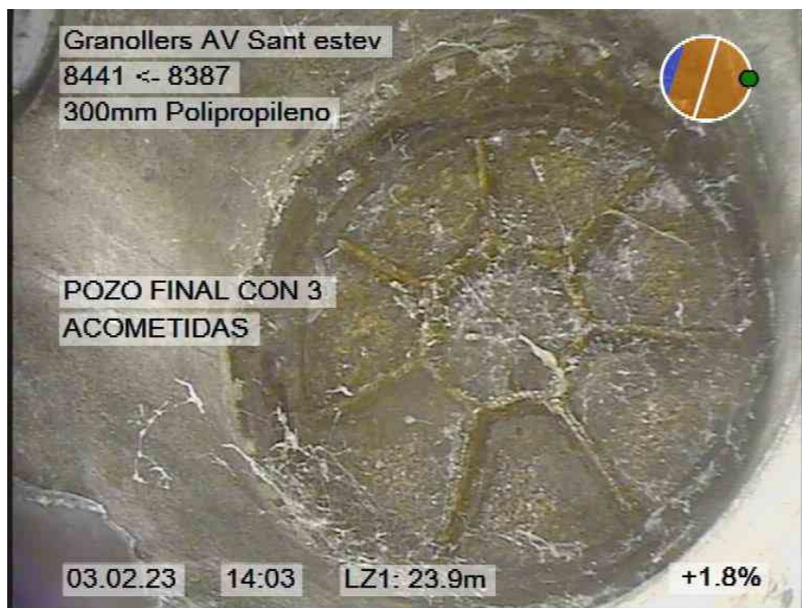
81.jpg, 00:01:56, 23.90m POZO FINAL CON 3 ACOMETIDAS
