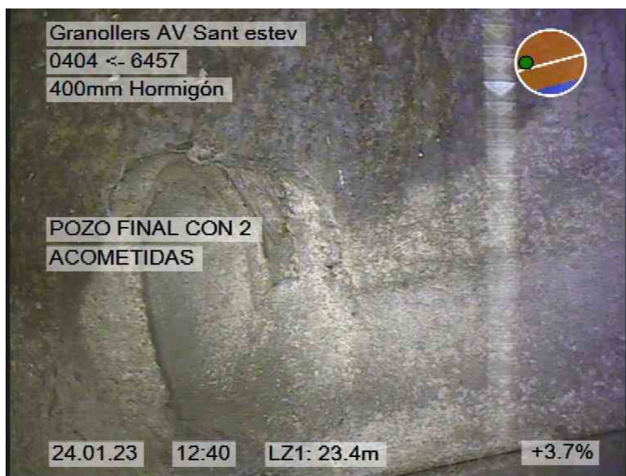
6.jpg, 00:02:53, 23.40m POZO FINAL CON 2 ACOMETIDAS
