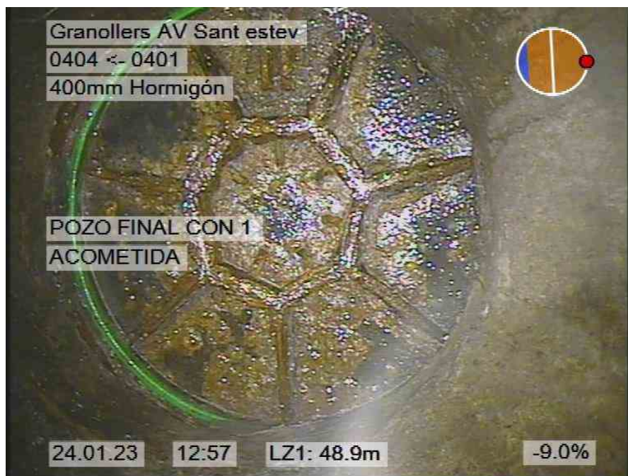
18.jpg, 00:04:50, 48.90m POZO FINAL CON 1 ACOMETIDA
