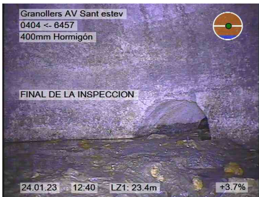
8.jpg, 00:03:01, 23.40m FINAL DE LA INSPECCION
