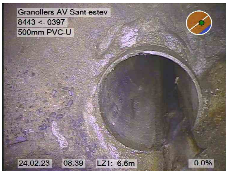
199.jpg, 00:01:37, 6.60m POZO FINAL CON 3 ACOMETIDAS
