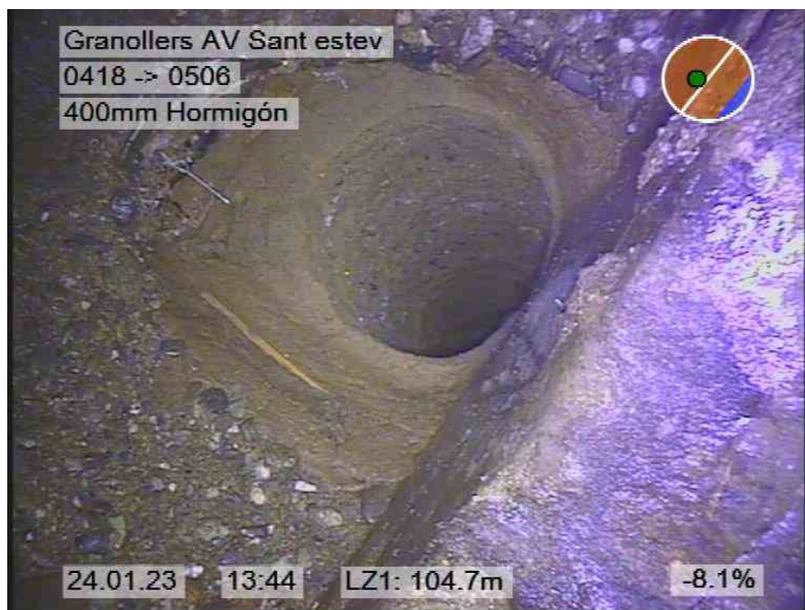
51.jpg, 00:10:23, 104.70m POZO FINAL CON 2 ACOMETIDAS
