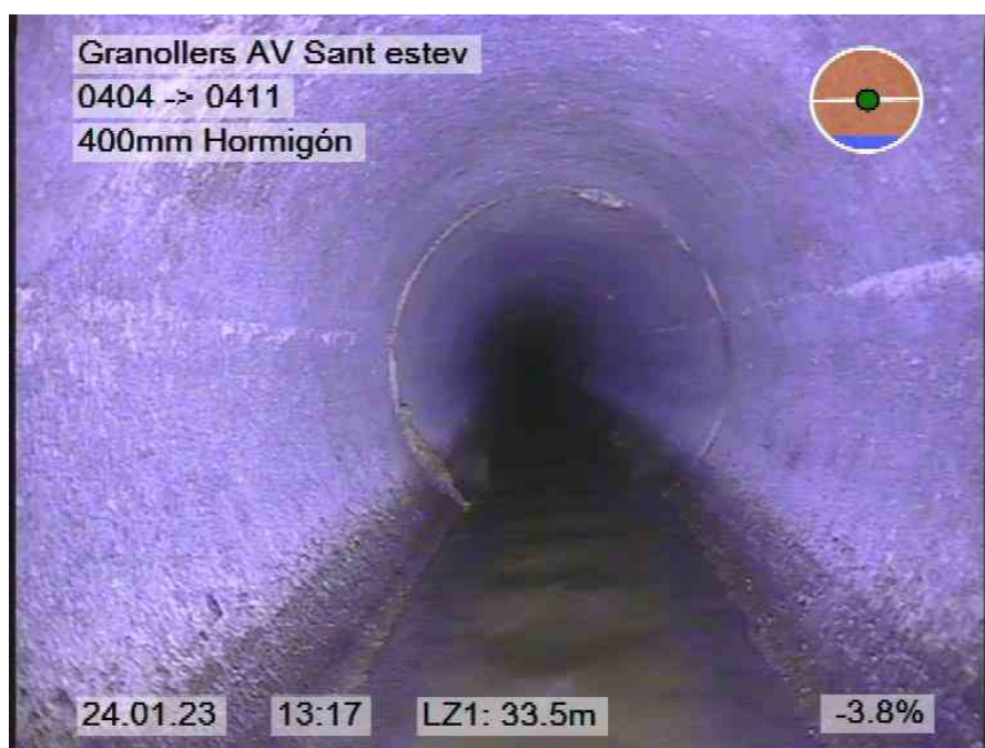
27.jpg, 00:02:43, 33.50m FINAL DE LA INSPECCION
