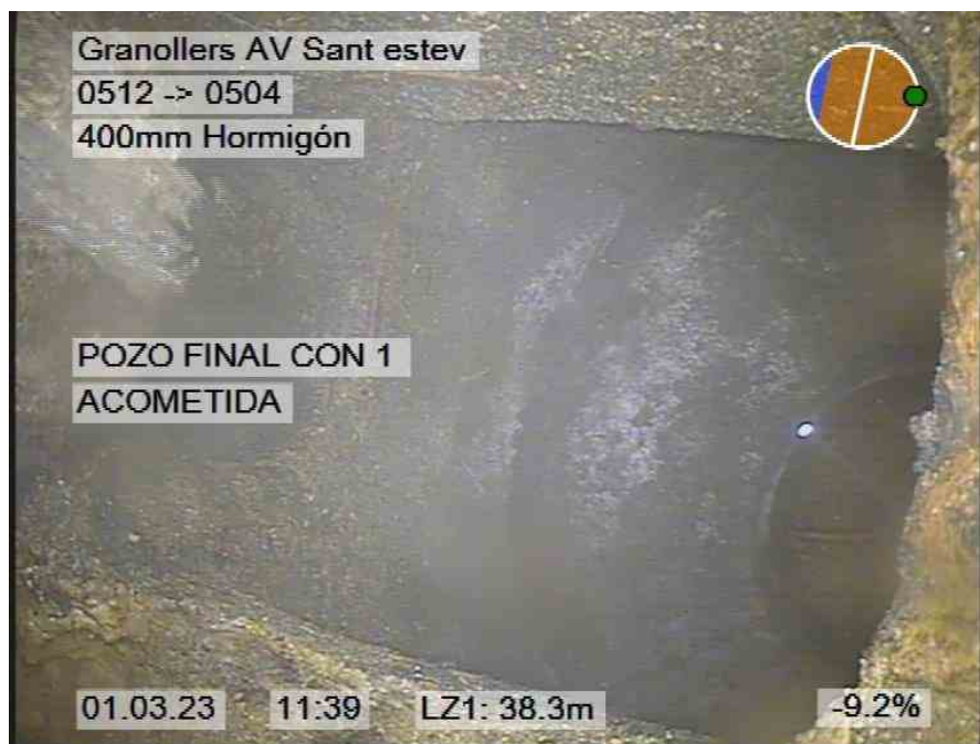
231.jpg, 00:04:23, 38.30m POZO FINAL CON 1 ACOMETIDA
