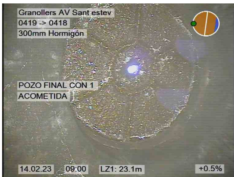
156.jpg, 00:01:57, 23.10m POZO FINAL CON 1 ACOMETIDA
