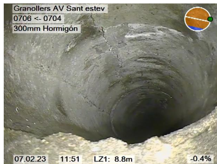
Figura 2: Imatge inspecció escomesa
