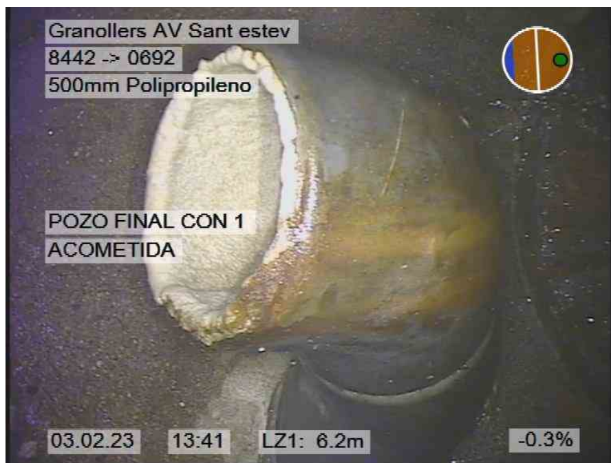
76.jpg, 00:01:00, 6.20m POZO FINAL CON 1 ACOMETIDA
