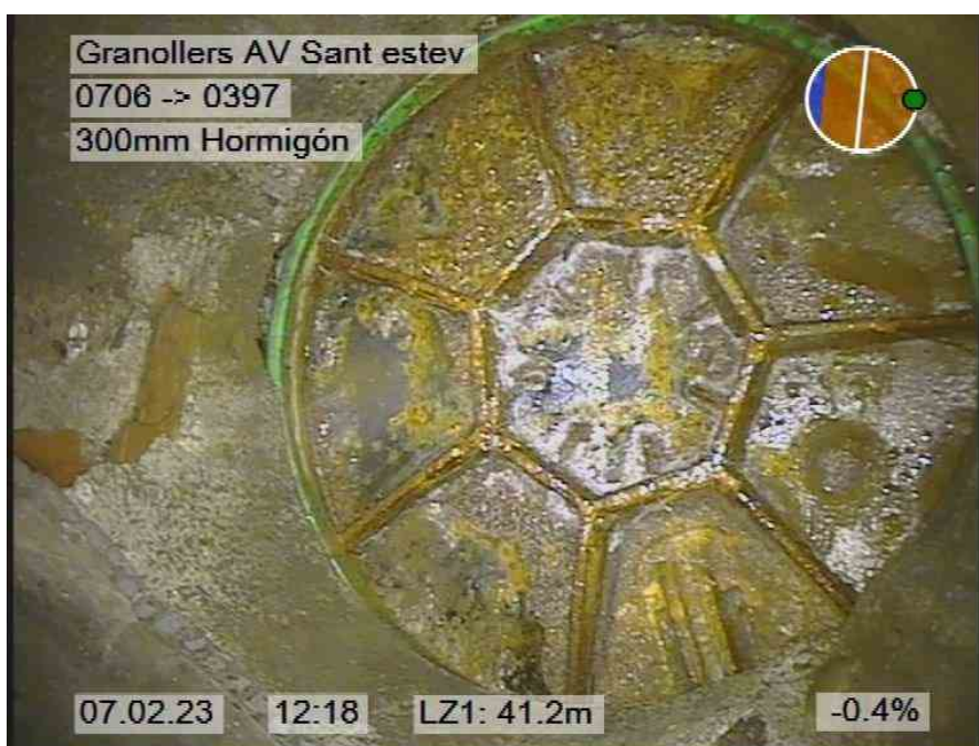
143.jpg, 00:04:05, 41.20m POZO FINAL CON 3 ACOMETIDAS
