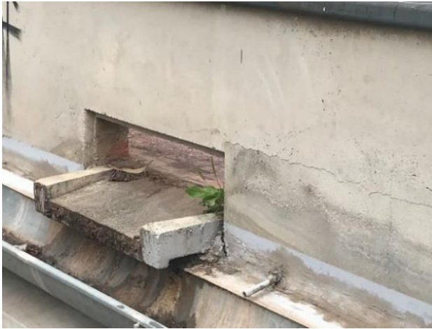
Obertures de desguàs en coronament façana
