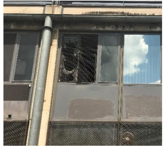
Canal i baixants en façana
