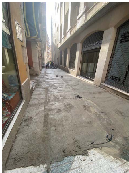
Vista del tram amb paviment provisional
