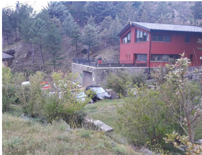
Imatge 10: Edifici dels Agents Rurals.
