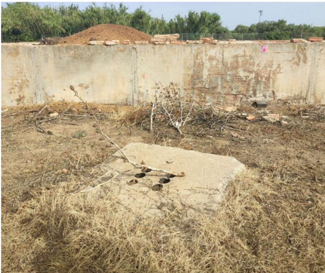
Fotografia 6 Arqueta general d'aigües pluvials existent a eliminar
