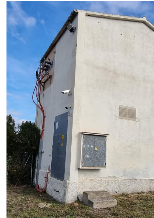
Façana centre de transformació existent
