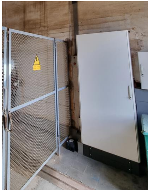
Recinte ubicació QGD existent
