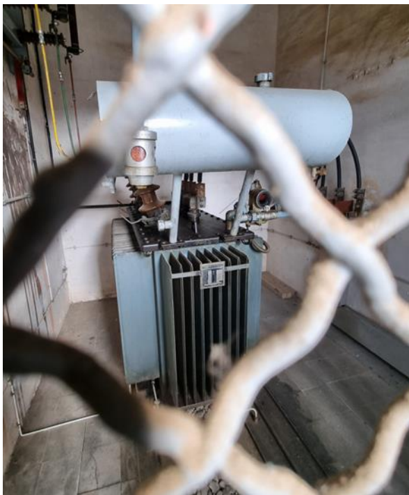
Substitució de transformador existent
