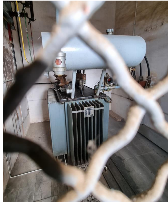
Transformador existent
