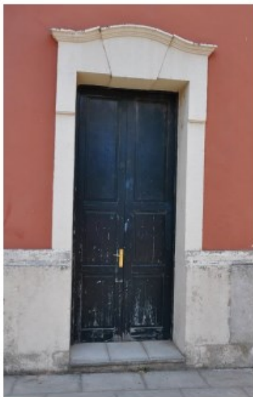
Fotografia de l'estat actual de la porta de fusta de la façana nord
