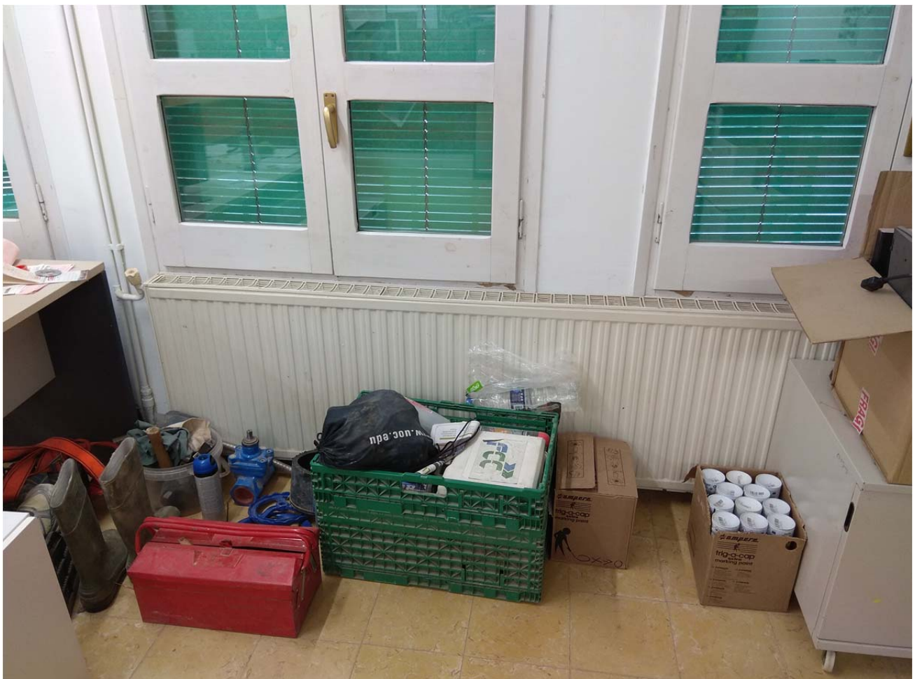
Vista de la fusteria, paviment, parets i calefacció de l'aula sociocultural
