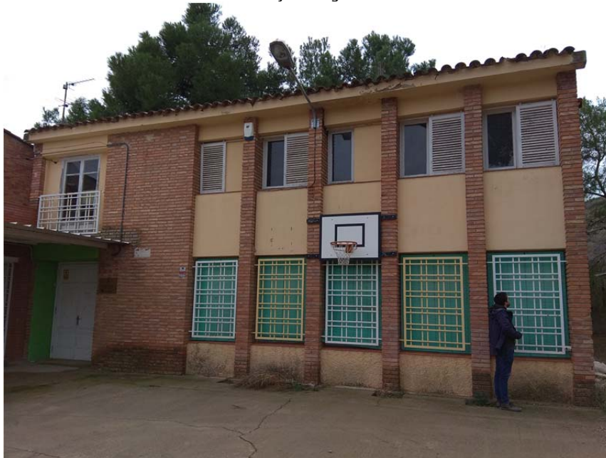
Façana principal (est) edifici antigues escoles
