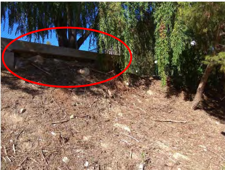
Vistes del talús amb pèrdua evident de material (dreta: pista poliesportiva; esquerra: piscines)
