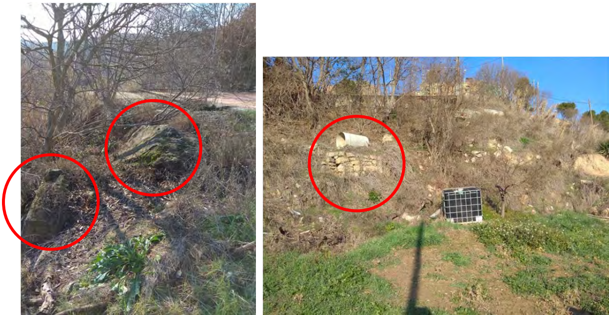
Imatges de murs de mamposteria testimonials
