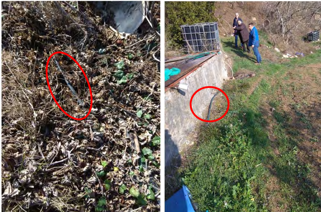
Vista serveis existents
