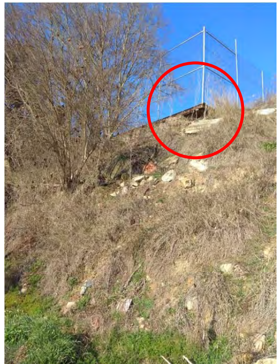
Vistes del talús amb pèrdua evident de material (dreta: pista poliesportiva; esquerra: piscines)
