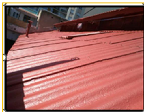
2ª FASE Aplicació de la 2ª capa fixadora de color distint a l'aplicació de la 1ª capa
