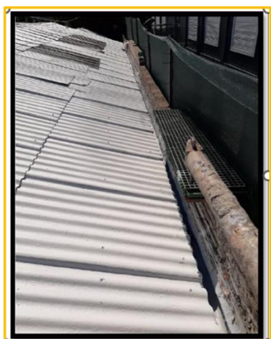
1ª FASE Aplicació de la 1ª capa fixadora de color distint a l'aplicació de la 2ª capa
