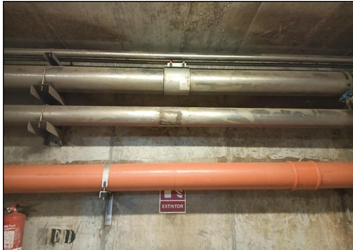
Imatge 2.- Punt on s'ha de posar la T, on està situada la brida (canonada superior).
