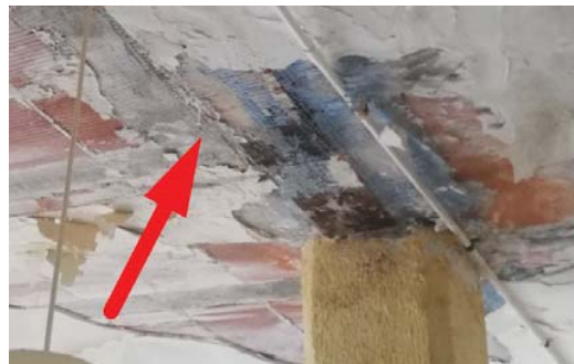
In 9: Vista de la jàssera HEB-160
