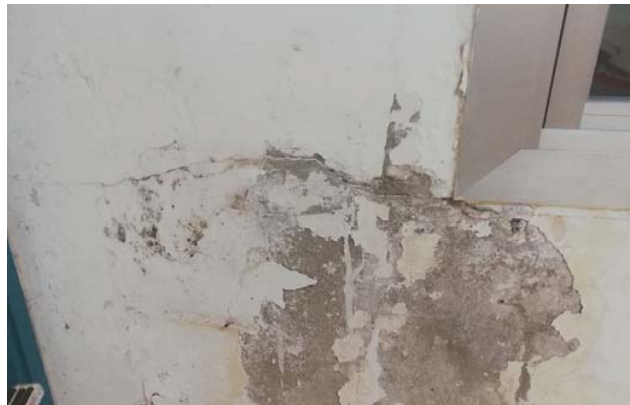
In 29: Exemple d'esquerda vinculada a una finestra
