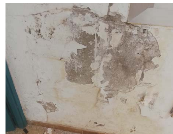
In 17: Detall de la taca d'humitat.
