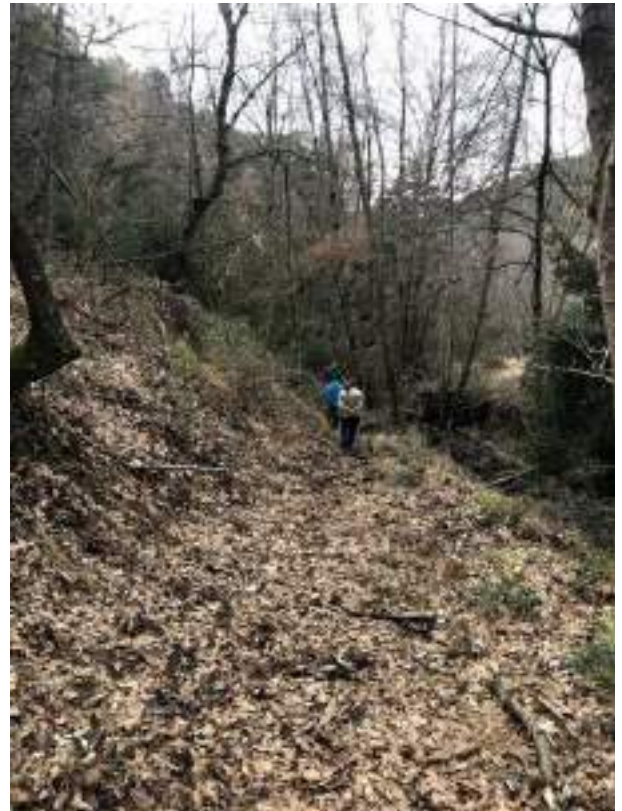
Foto 15: Tram de camí que enllaça amb el camí a construir.
