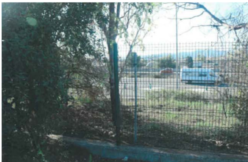
Fotografia zona tanca perimetral trencada
