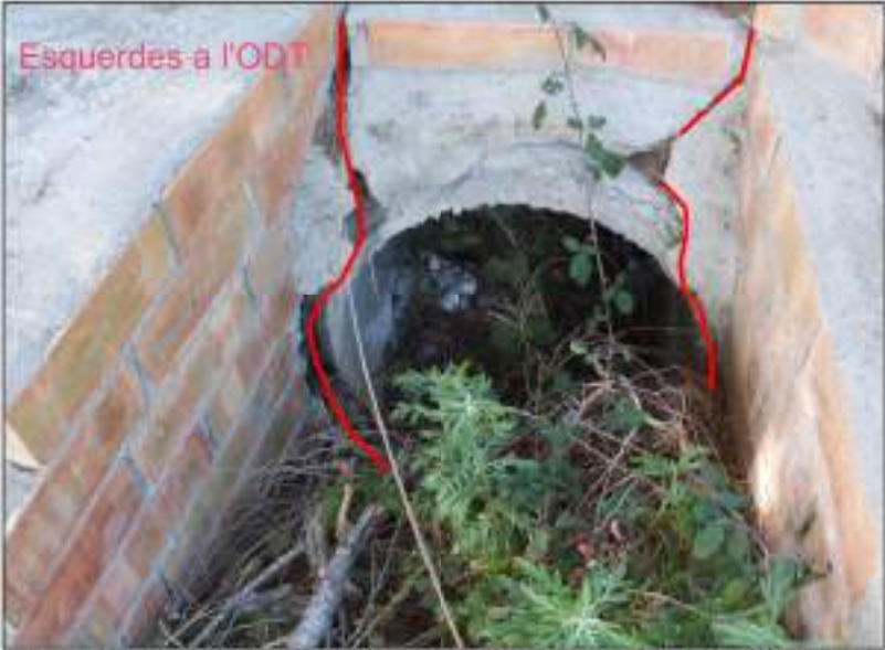
Figura 6. Aspecte actual de l'entrada de l'obra de drenatge transversal ODT-1+776, ICGC (2022)
