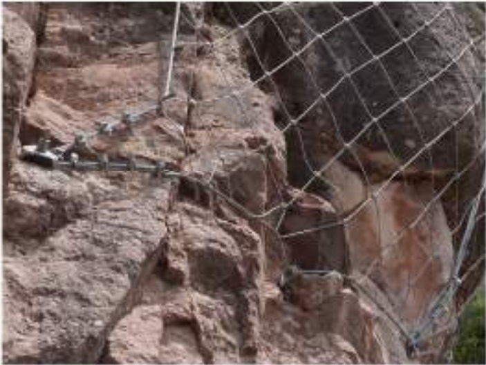
Fotografia 1: Detall del lligat de cable perimetral amb pern d'ancoratge
