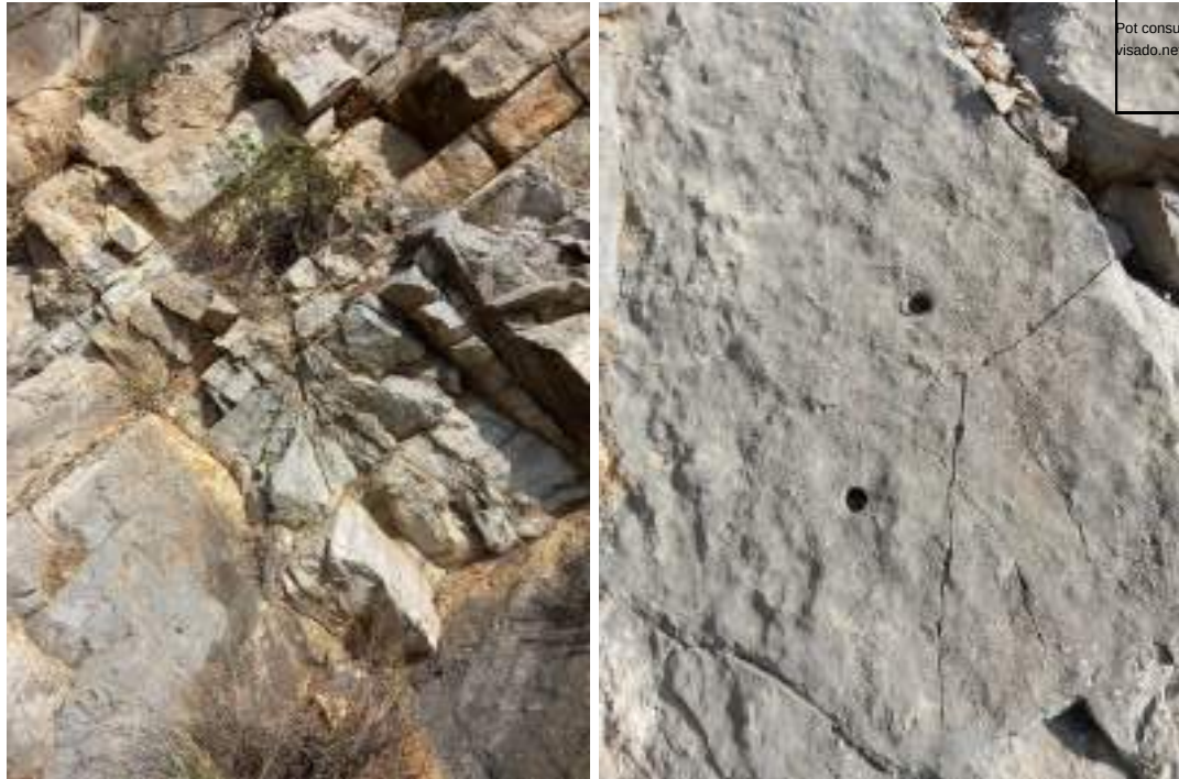
Figura 5. Descompressió i fractures induïdes per l'efecte del minat del desmunt
