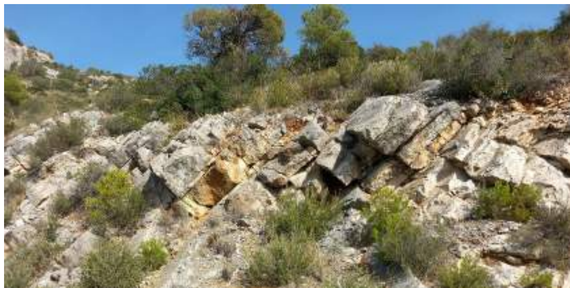
Figura 15. Detall de la colonització d'arbustos a la capçalera del talús
