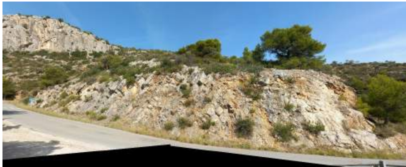
Figura 6. Aspecte general del talús PG01TA13D
