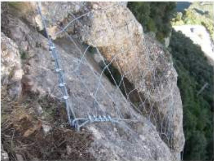
Fotografia 2: Detall del lligat de cable perimetral amb eslinga d'ancoratge
