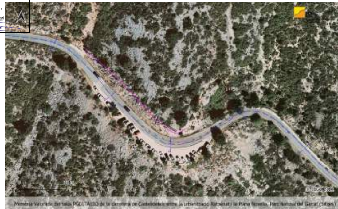
Figura 2. Localització del talús PG01TA13D. Oortofoto 1:1.000 ICGC (2021)
