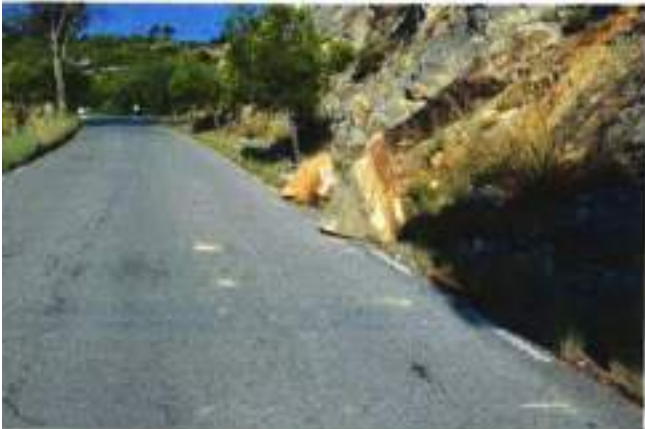
Figura 3. Lliscament de tipus falca, octubre de 2016 (font: Gerència de Serveis d'Espais Naturals).
