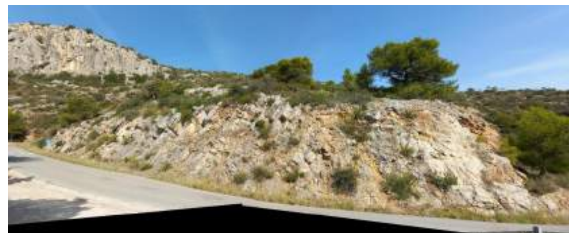
Figura 2. Aspecte general del talús PG01TA13D
