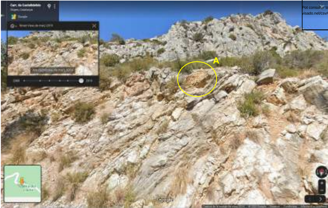
Figura 5. Despreniment < 1tn datat entre l'any 2016 i el 2019. Foto comparativa del 2019.
