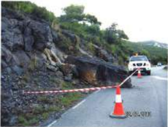
Figura 2. Lliscament planar al PK 1+040, juliol 2013 (font: Gerència de Serveis d'Espais Naturals).
