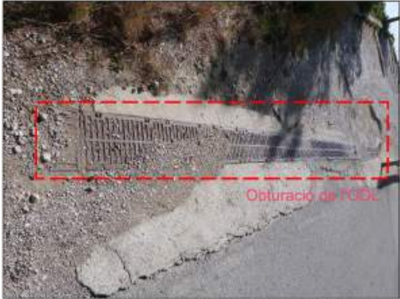
Figura 8. Aspecte actual de l'obra de drenatge longitudinal ODL-1+782, ICGC (2022)
