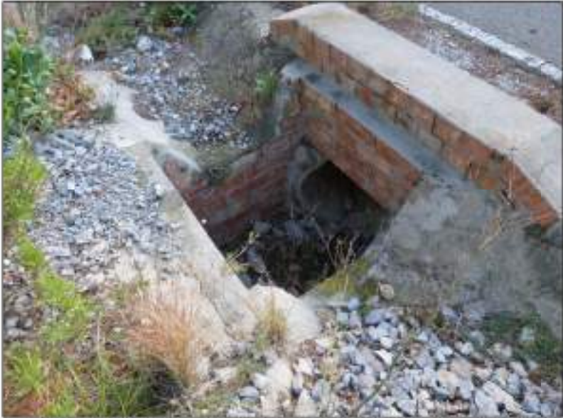
Figura 7. Aspecte actual de la sortida de l'obra de drenatge transversal ODT-1+776, ICGC (2022)
