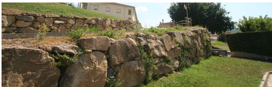
MURS DE CONTENCIÓ DE LA BAIXADA A LA PISTA DE BÀSQUET DESCOBERTA
