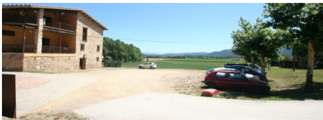
ZONA PAVIMENTADA I DE SAULÓ
