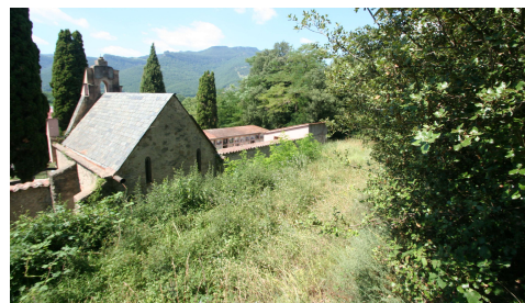
ZONA DE DARRERE DES DE DOS ANGLES
