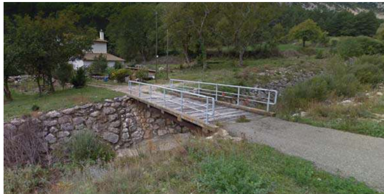
Figura 8. Passarel·la d'accés a Cal Roset. (Font: Google maps)
