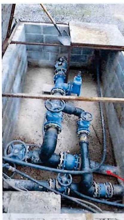
Vista de nord a sud de l'interior de l'arqueta d'arribada.
