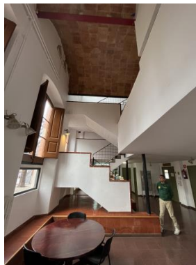
*Sostre unidireccional de la planta baixa i primera amb bigues d'acer i pilar metàl·lic.
