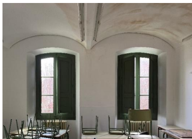
*Voltes d'escaiola i estructura subjecció a planta segona.
