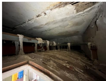
*Sostre unidireccional de la planta baixa i primera amb bigues d'acer i pilar metàl·lic.
