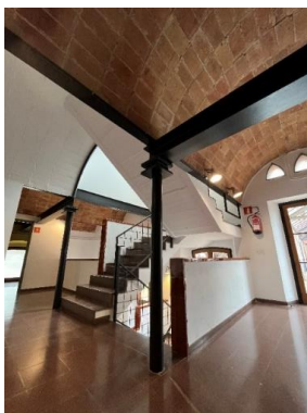
*Sostre unidireccional de la planta baixa i primera amb bigues d'acer i pilar metàl·lic.
