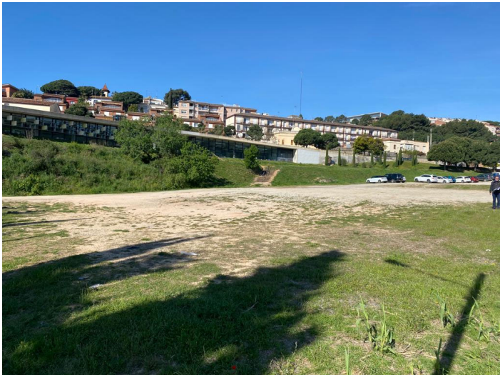
Zona construcció nou skatepark, vista entrada
