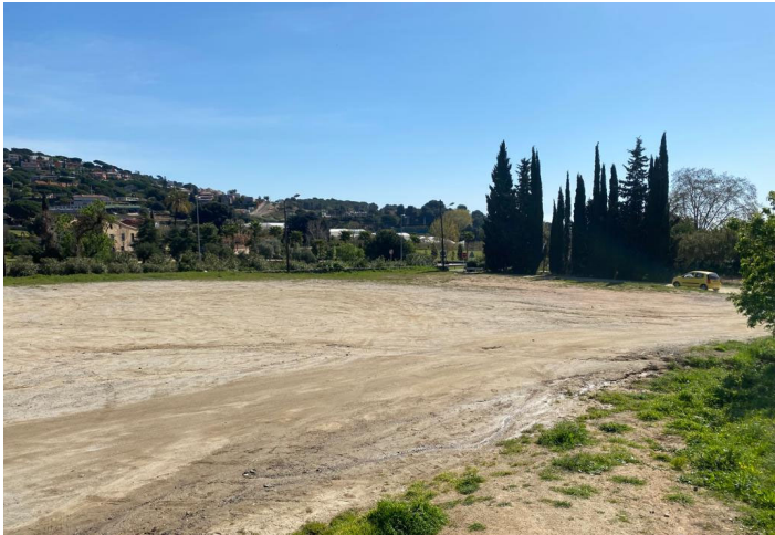
Zona construcció skatepark, vista contraposada
