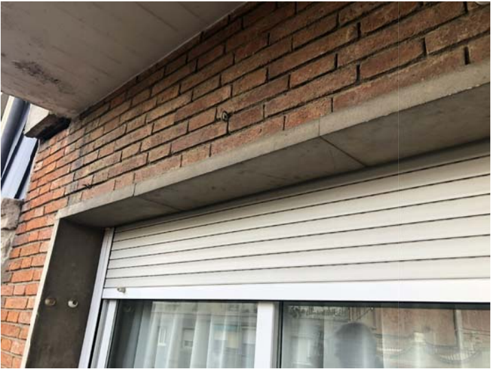
FOTOGRAFÍA DINTELL BALCONERA TERRASSA
