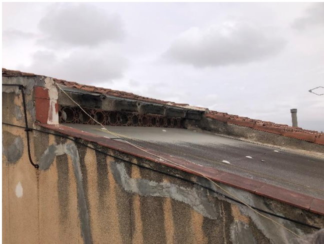
Coberta pati ascensors
