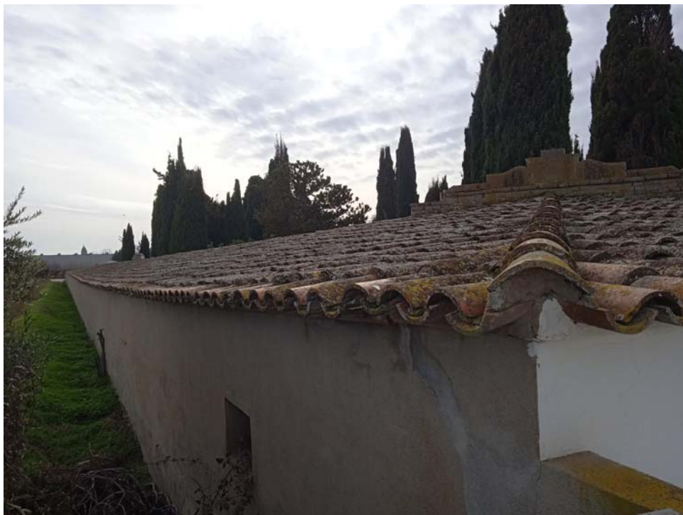
Foto 3: Zona nord de la coberta dels nínxols de cementiri.
