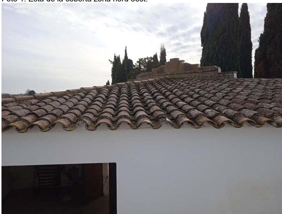
Foto 2: Estat zona nord coberta.
