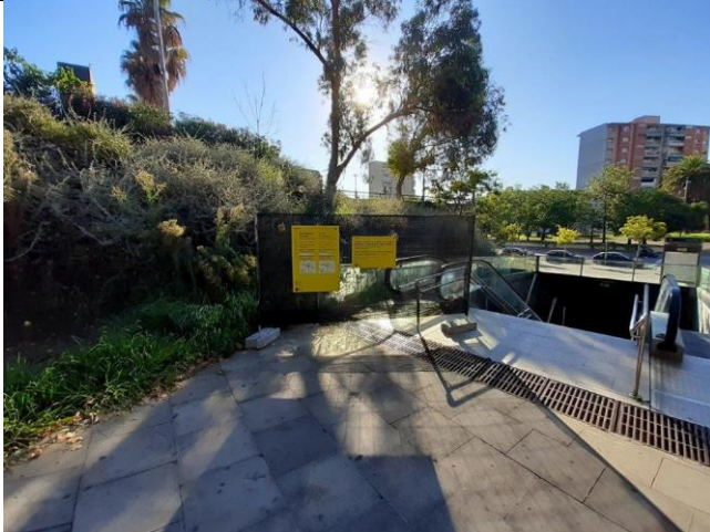
Senyalització i delimitació de la zona de treball
