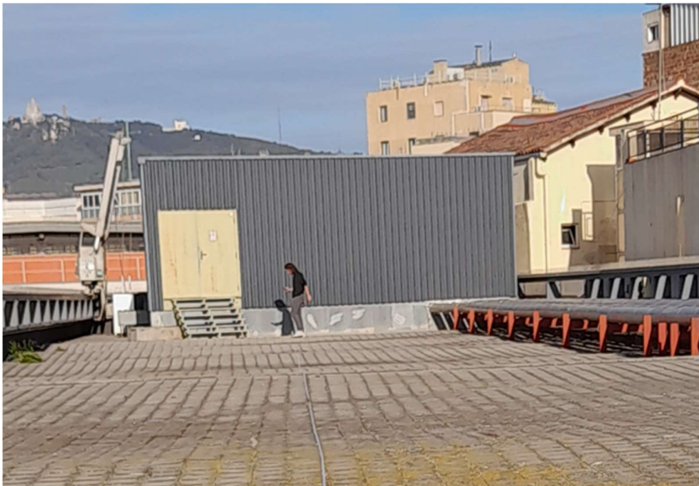
Imatge 6. Estat actual de la coberta de l'edifici. Zona 1 (Nord)
