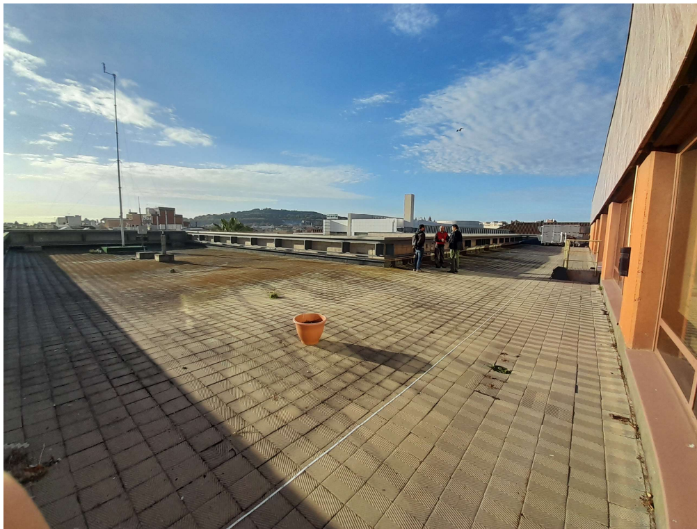
Imatge 9. Estat actual de la coberta de l'edifici. Zona 3 (Sud)
