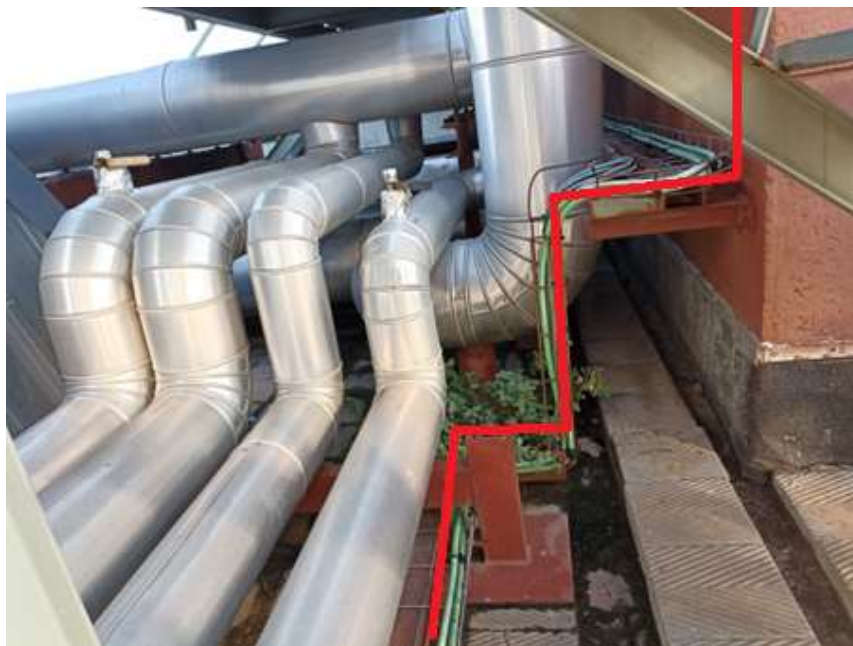
Imatge 21. Safata per a la estesa del cablejat de CA (inversor de 100 kWn)
