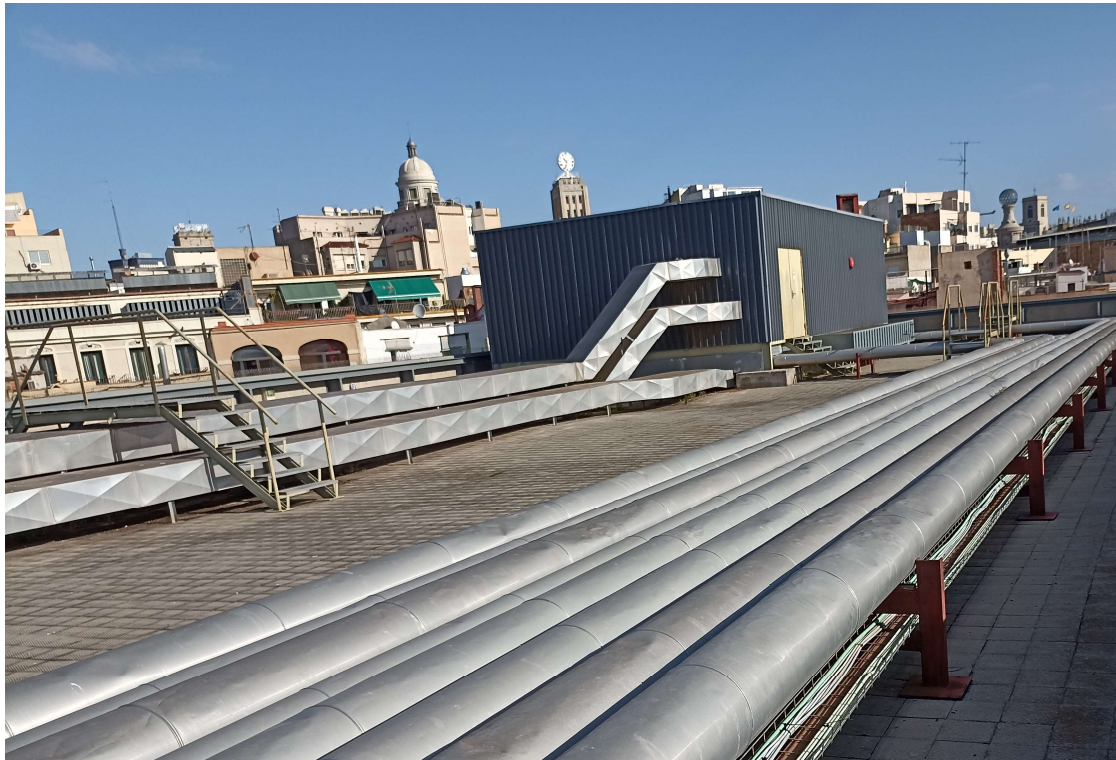
Imatge 8. Estat actual de la coberta de l'edifici. Zona 2
