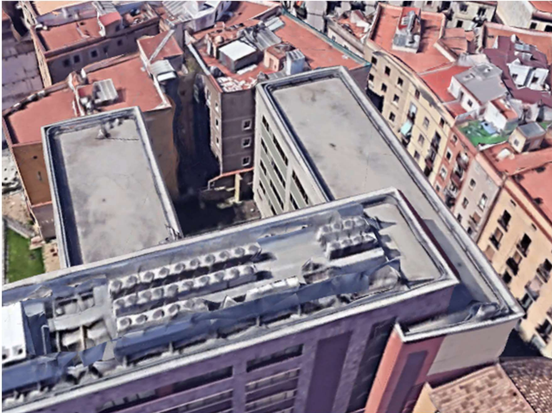
Imatge 10. Estat actual de la coberta de l'edifici. Zones 4 i 5
