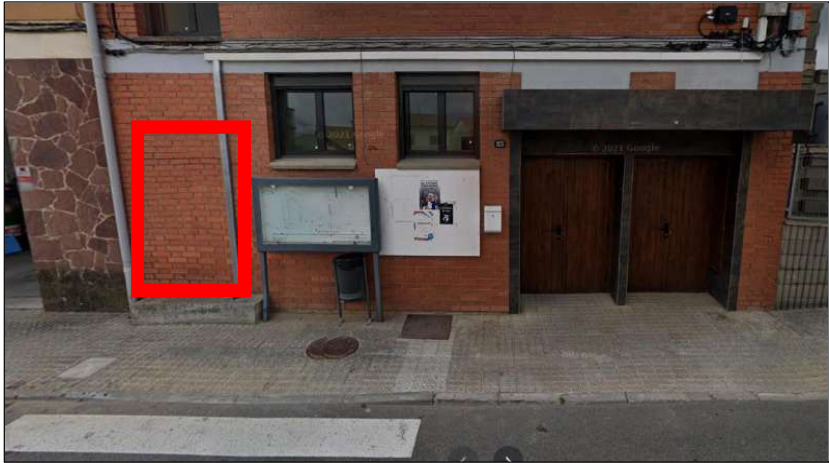
Imatge 5.- Nova ubicació del quadre Q03.
