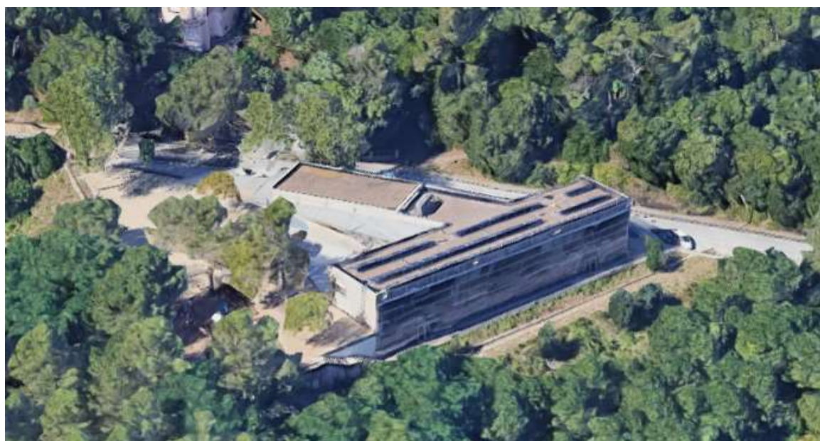
Imagen 2: Perspectiva aérea del edificio.
