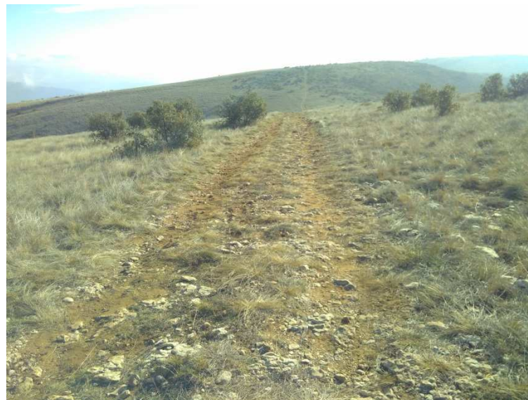
Camí de l carena de Sant Mamet: tram a arranjar amb trituradora de pedres i en el que es farà FAT de 1+1 m.
