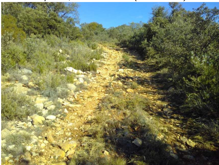
Camí de l carena de Sant Mamet: tram a arranjar amb trituradora de pedres i en el que es farà FAT de 2+2 m.
