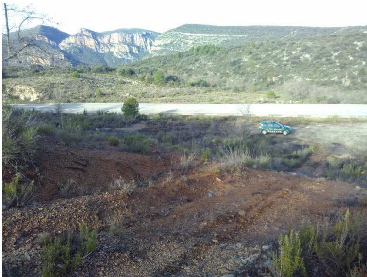
Camí d'Altavista: entrada del camí des de la C-13 del traçat actual, que es descarta per pendents excessius (a la foto 35%).
