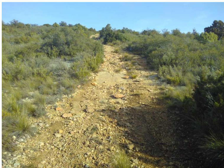
Camí d'Altavista: tram de camí de pendent vàlid que es conserva i s'arranja. També s'hi fa FAT de 1+1 m.
