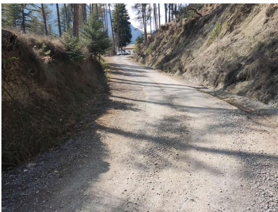
Foto nº3. Tram final de la pista a formigonar.
