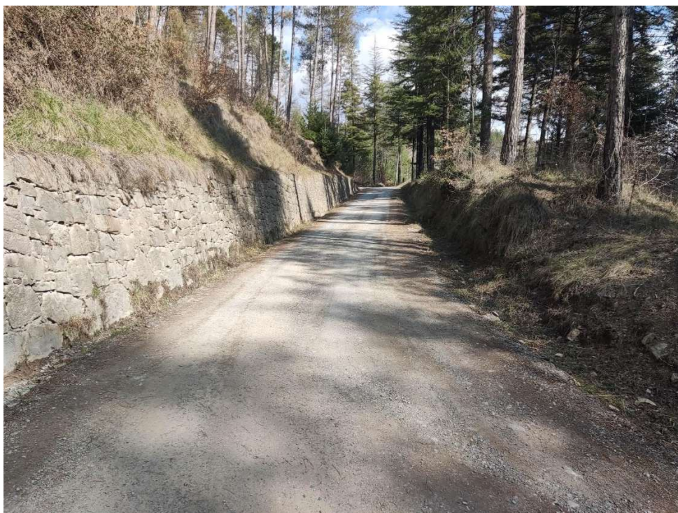
Foto nº2. Tram intermig de la pista a formigonar.
