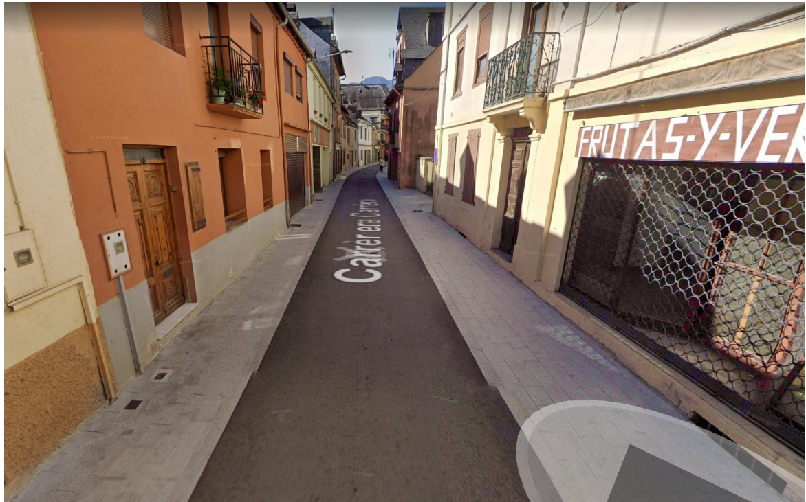
Imatge 5. Estat actual d'un sector del tram 1 del carrer Carrera ja reformat.
