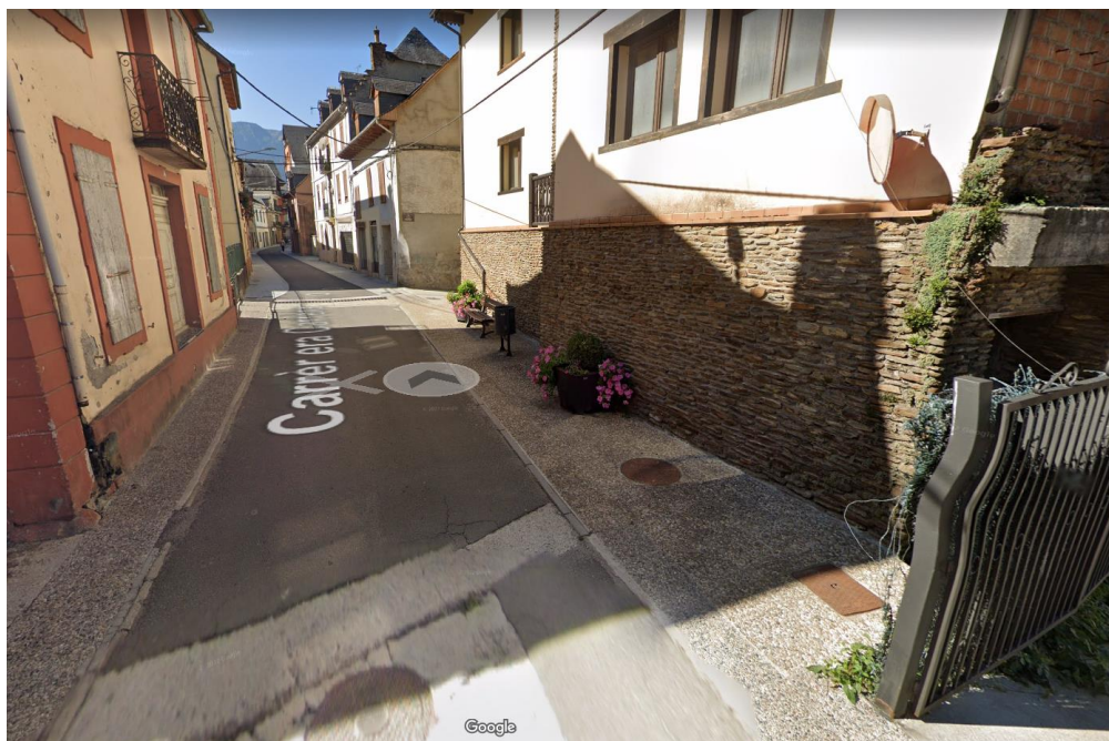
Imatge 4. Secció de ferm apedaçat per dur a terme connexions als pous de clavegueram. Al fons s'ubiquen els elements de mobiliari urbà a conservar.
