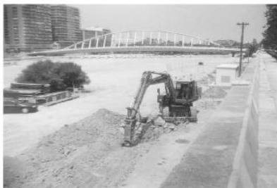
DEMOLICIÓN MECÁNICA A CIELO ABIERTO
