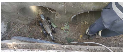
INICIO DE TUBO 2 Y 1 DE PLUVIAL
