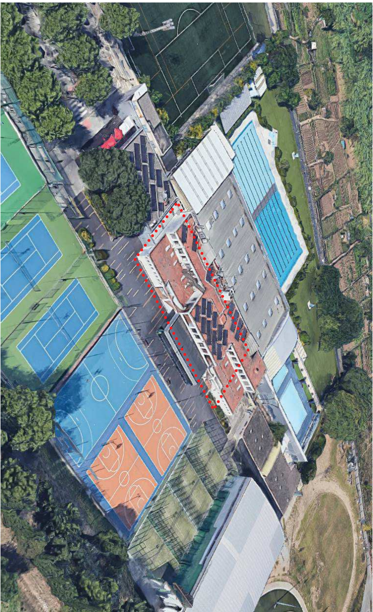
A1.9.1 FOTOGRAFIES D'ESTAT ACTUAL (previ obra primera fase)
