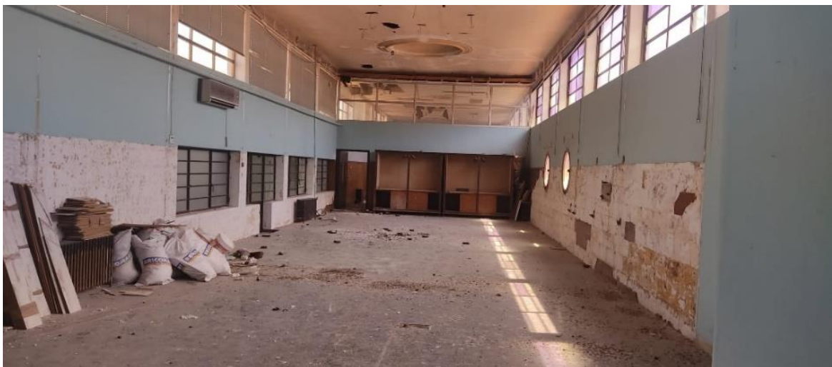
Imatges interior cos d'oficines
