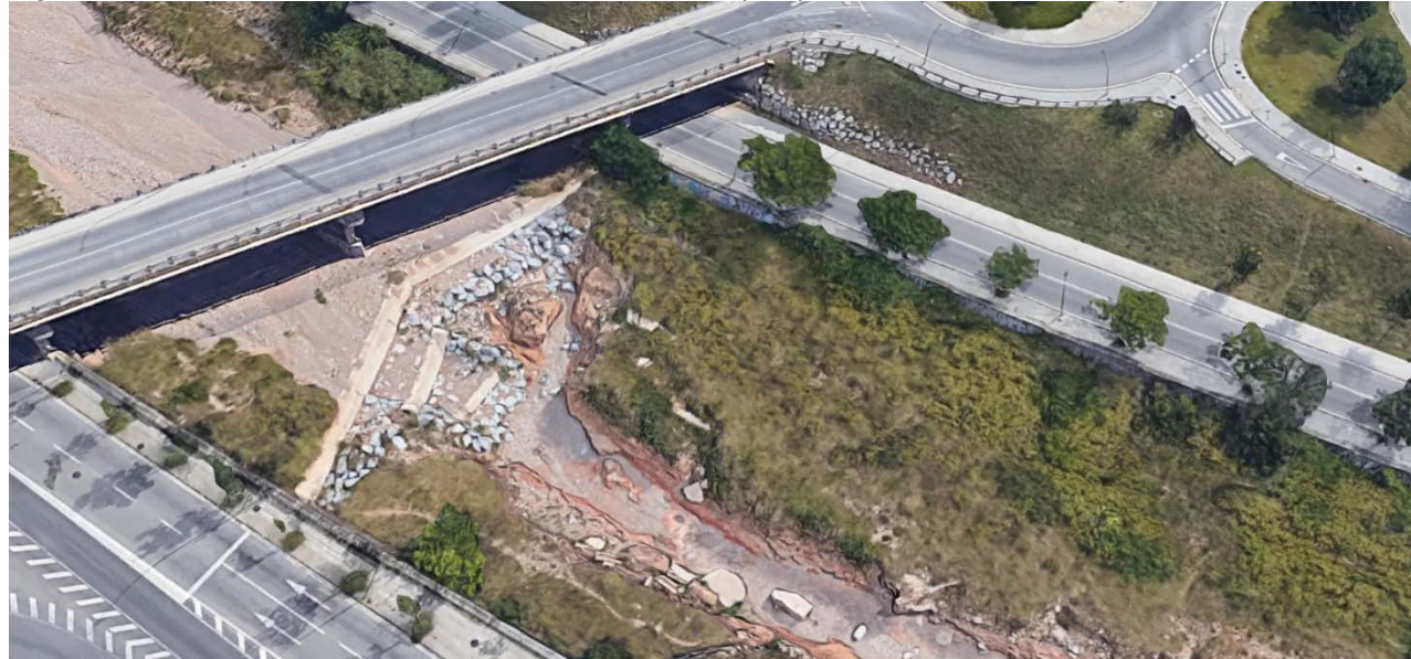
Figura número 1. Estat de la Riera de les Arenes al seu pas per la zona del Pont Montserrat
