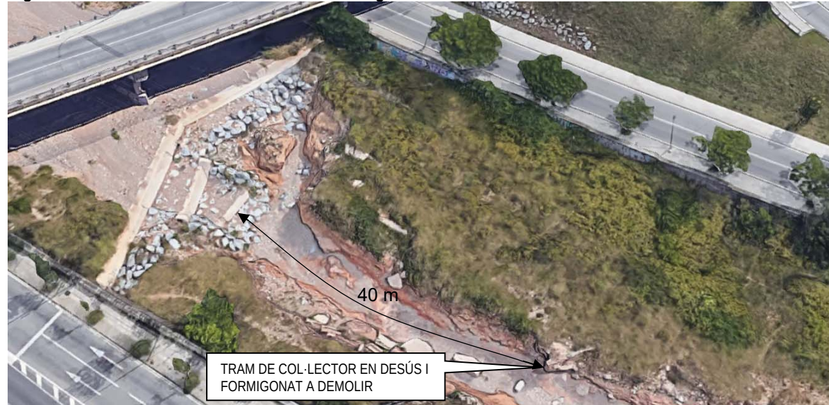
Figura 5. Situació del tram de col·lector formigonat a demolir
