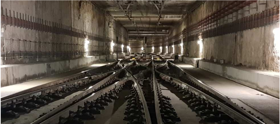
Zona de la bretelle a renovar al tram de Gorg. Vista en sentit La Salut.
