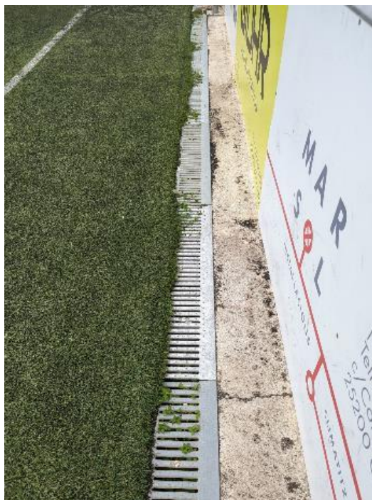
Imatge 8. Canal de desguàs existent
