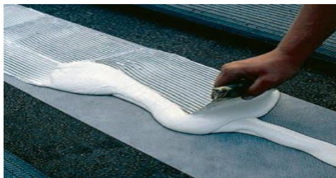
Encolat de juntes
