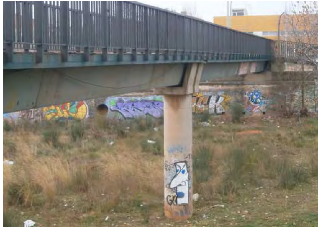
F1: Vista lateral sud de la passarel.la.
