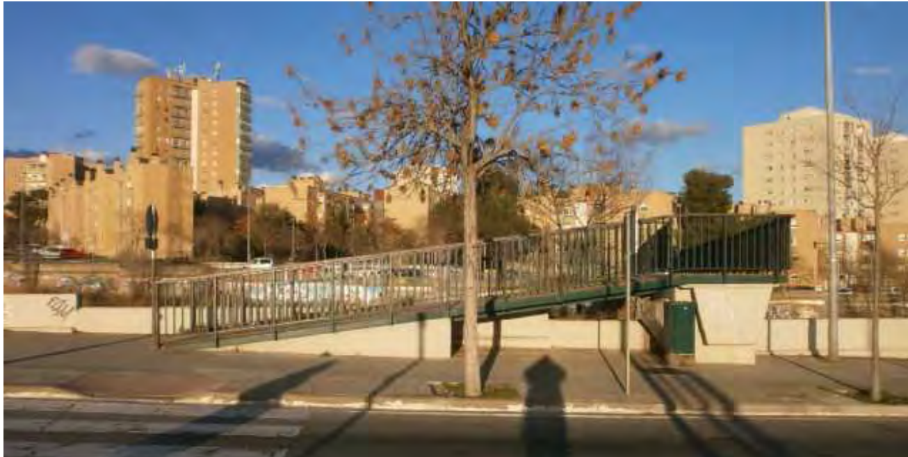
F1: Vista de la rampa d'accés a la passarel·la des del costat del barri de Sant Pere Nord. La pendent actual de la rampa supera el màxim establert actualment per la normativa d'accessibilitat.
