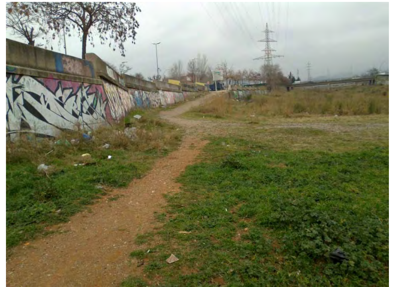
F7: Vista de l'accés en rampa actual a la riera de les Arenes, situat a uns 120m al nord de la passarel·la pel costat del barri de Sant Pere Nord.
