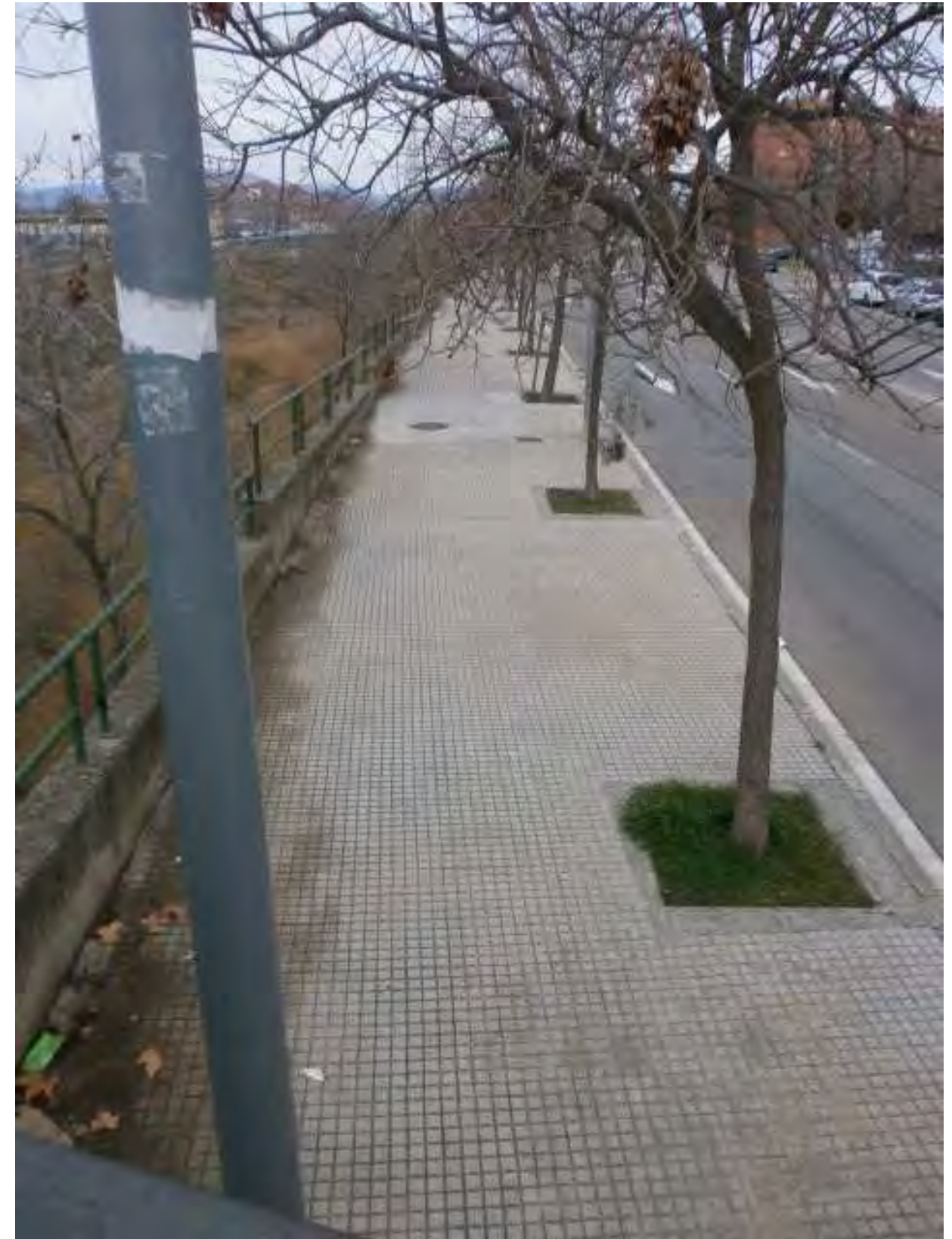
F5: Vista de la vorera on s'executarà la nova rampa. Aquests dos primers arbres caldrà eliminar-los per a poder garantir l'accessibilitat.
